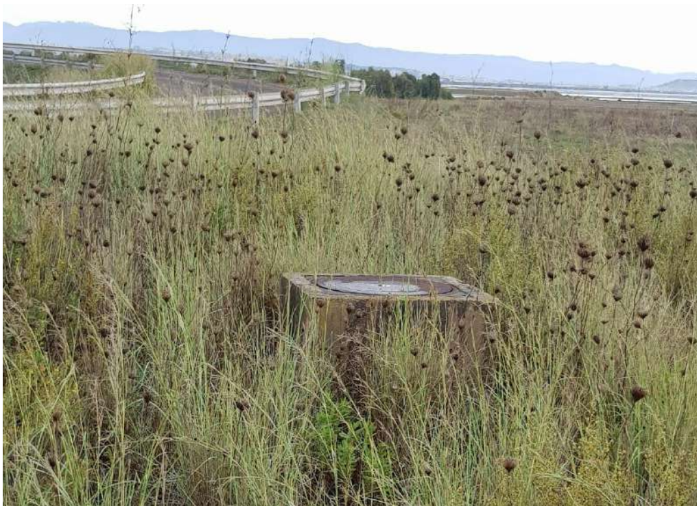
Figura 3 - Foto dell'interferenza (Pozzetto ispezione acquedotto)
