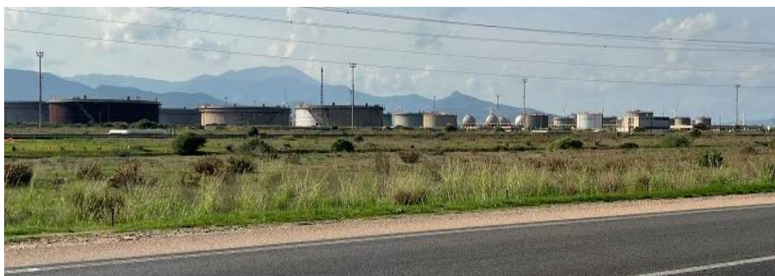
Figura 4.71 - vista tipica degli impianti industriali nell'area di progetto
