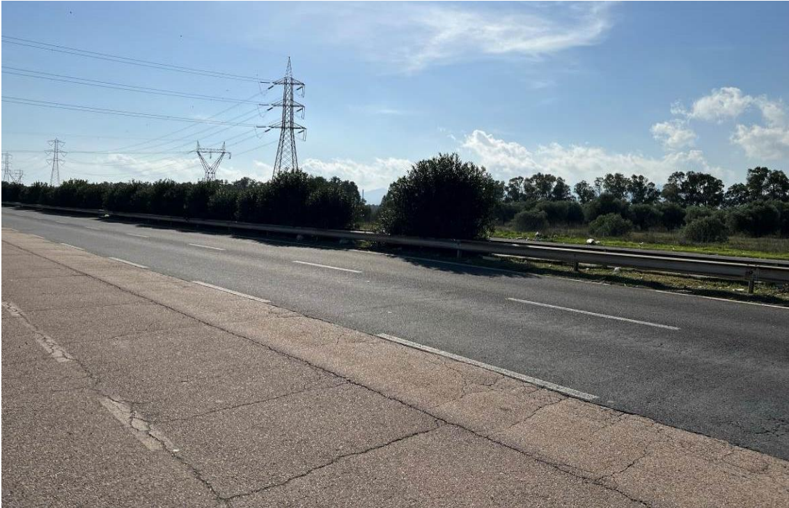
Figura 4.74L'infrastruttura attuale a inizio intervento
