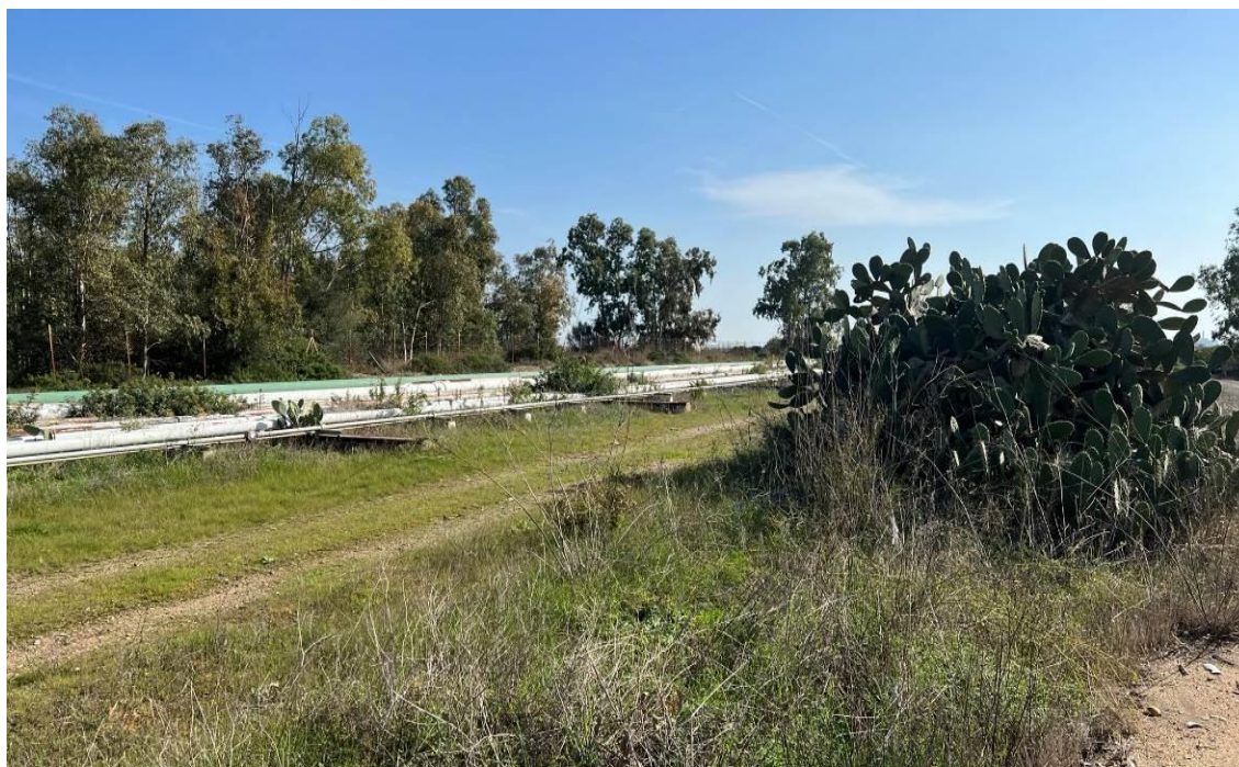
Figura 4.78 Fasci tubieri a servizio degli impianti
