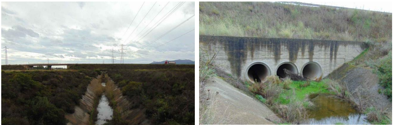
Figura 4.25 – Dettagli fotografici del canale Imboi e di un attraversamento
