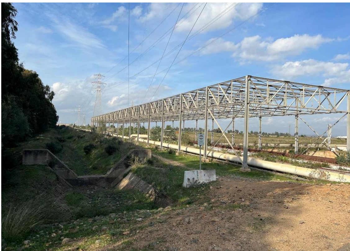
Figura 4.87 Vista del tratto che precede lo scavalco del fascio tubiero
