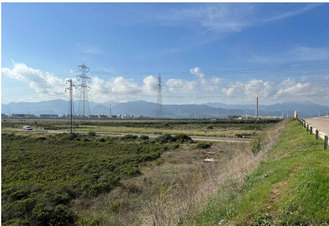
Figura 4.85 Vista dell'area di svincolo
