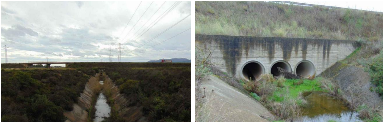
Figura 4.29 – Dettagli fotografici del canale Imboi e di un attraversamento che sarà demolito
