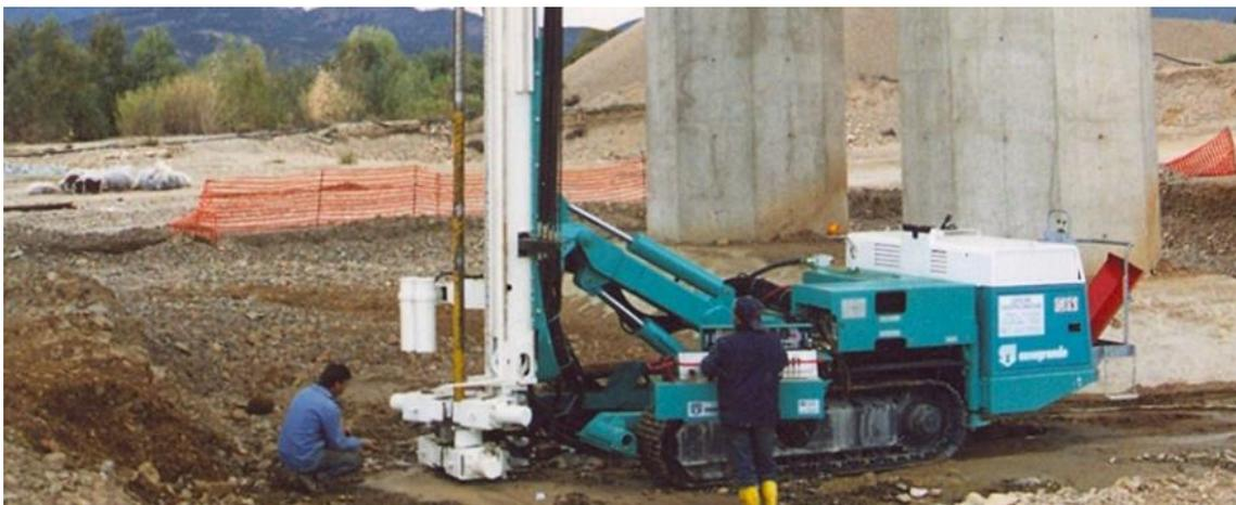
Figura 2.6: esempio di macchina per il jet grouting
