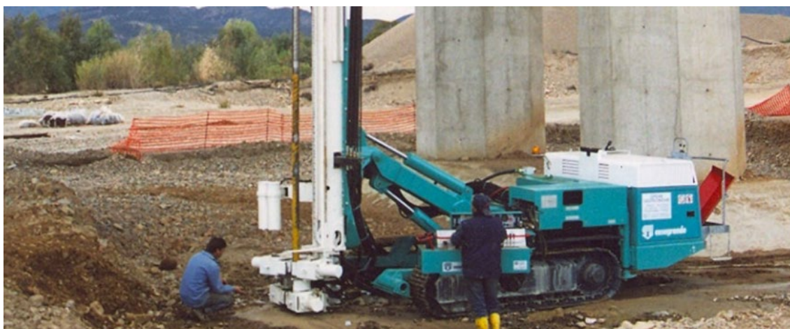
Figura 6.8: esempio di macchina per il jet grouting
