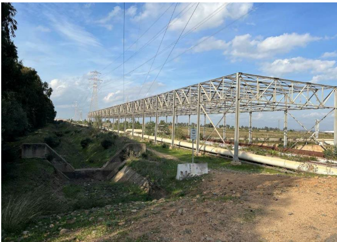
Figura 6.39 - Vista del tratto che precede lo scavalco del fascio tubiero
