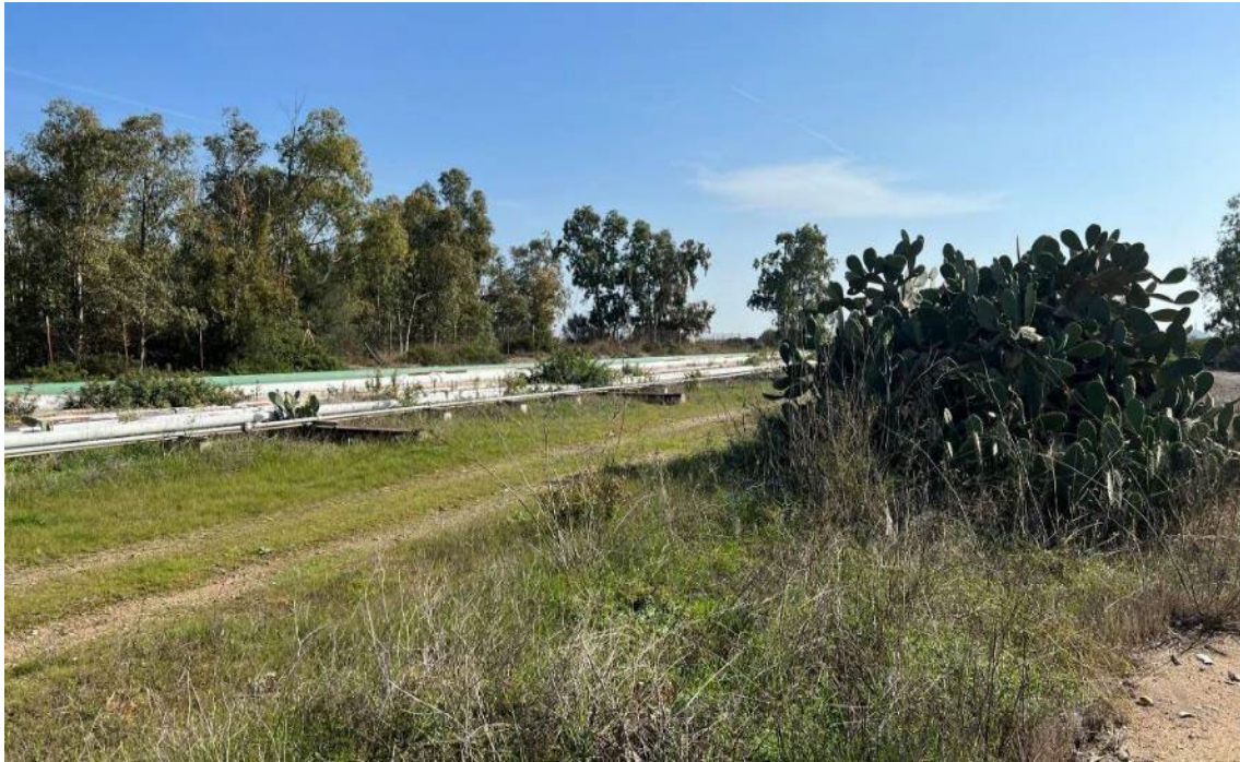
Figura 6.31 Fasci tubieri a servizio degli impianti
