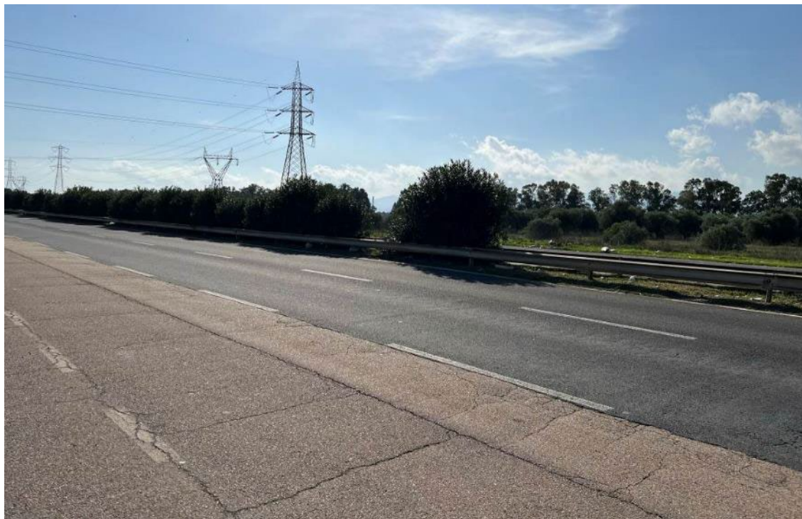
Figura 6.27 - L'infrastruttura attuale a inizio intervento
