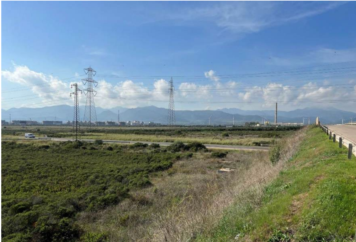
Figura 6.37 Vista dell'area di svincolo
