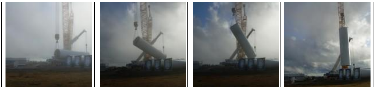
Figura 5.14 – Schema delle fasi di sollevamento dei componenti dell'aerogeneratore (Fonte sito web http://www.windfarmbop.com/ )
