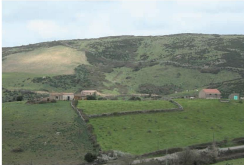
Figura 8.30: Immagine di come si presenta sul territorio uno stazzo con i suoi edifici e muretti a secco. (Fonte: I manuali di recupero dei centri storici della Sardegna, Volume V)
