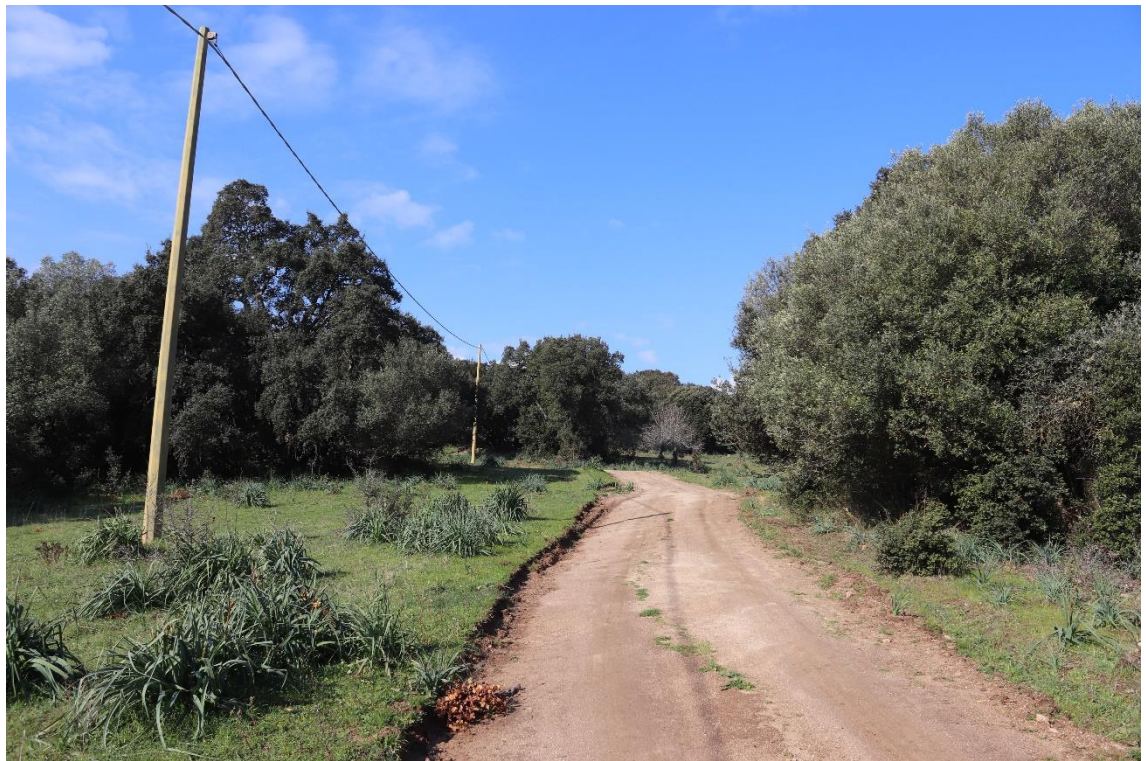
Figura 5.12 – Esistente viabilità in adeguamento lungo l'accesso alla postazione TL-10 facente parte della viabilità di progetto
