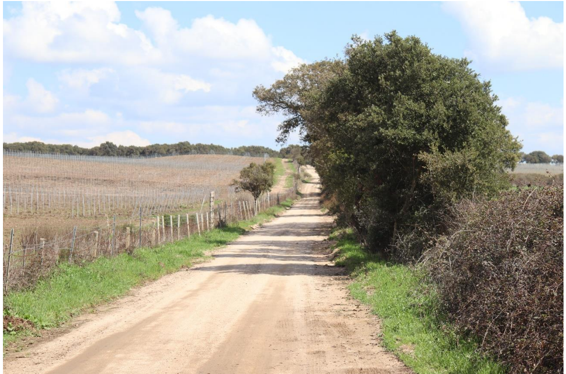
Figura 5.7 – Esistente viabilità in adeguamento lungo l'accesso alla postazione TL-09 facente parte della viabilità di progetto
