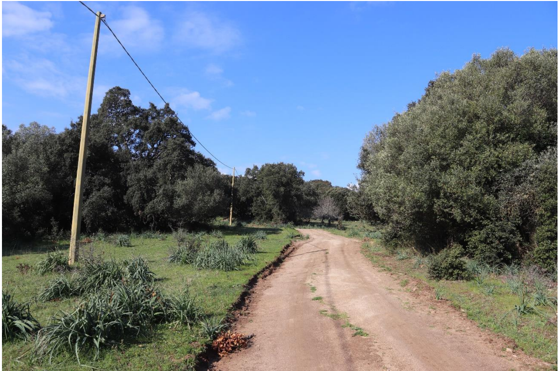
Figura 5.10 – Esistente viabilità in adeguamento lungo l'accesso alla postazione TL-10 facente parte della viabilità di progetto
