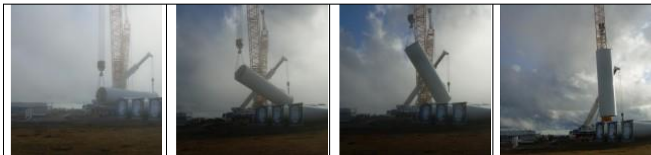
Figura 5.23 – Schema delle fasi di sollevamento dei componenti dell’aerogeneratore (Fonte sito web http://www.windfarmbop.com/ )
