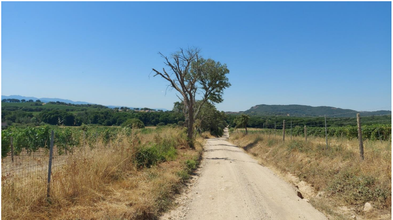
Figura 40 - Sterrato da adeguare
