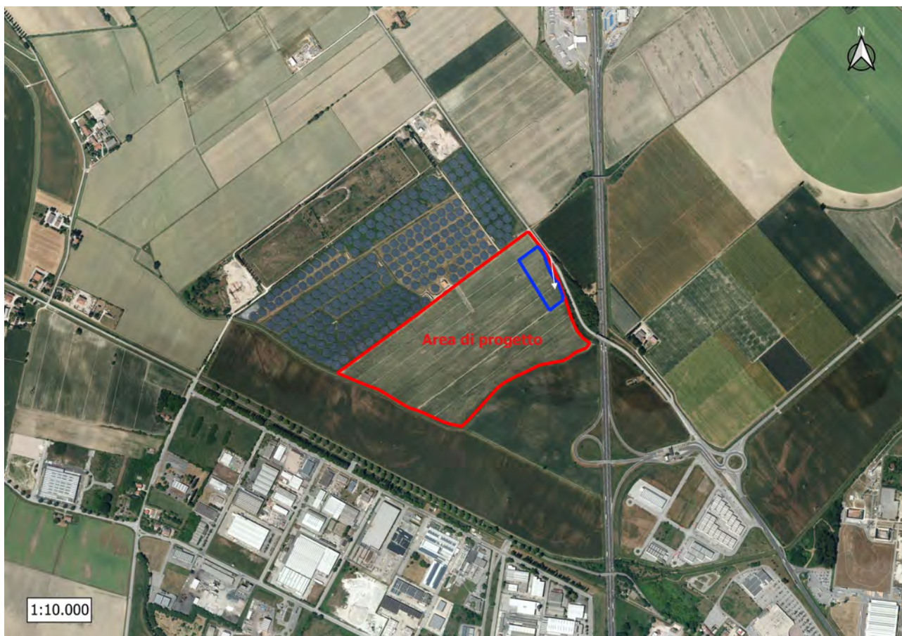
Figura 5: indicazione dell'area di cantiere (in blu) con relativo ingresso (freccia bianca)
