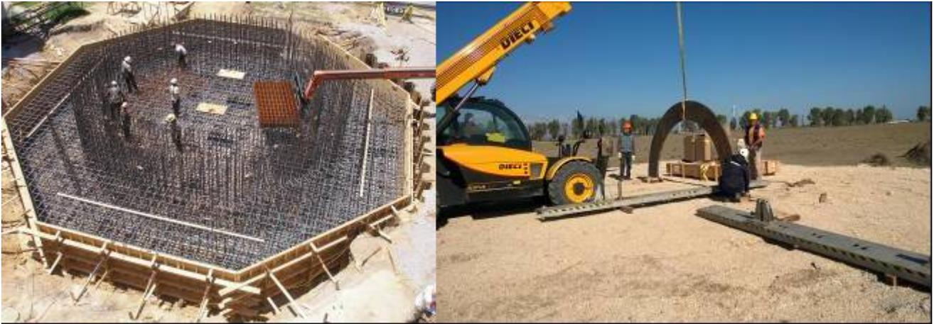
Trattasi della realizzazione di strutture in acciaio assemblate in opera mediante bullonature e/o saldature, per realizzazione fondazione pala eolica.
