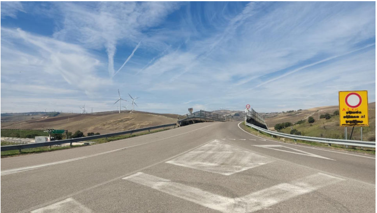
Foto 40a – Punto di Presa n° 40 Stato di Fatto
