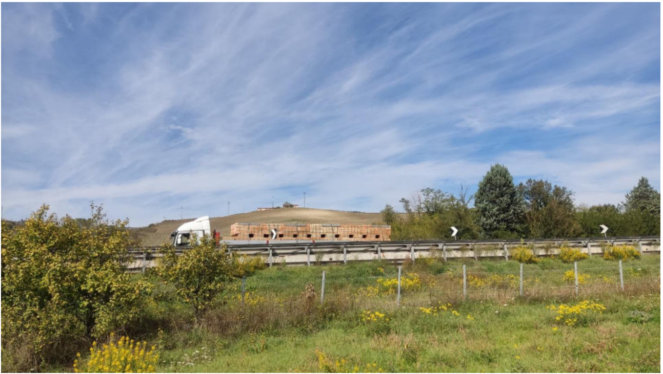
Foto 39a – Punto di Presa n° 39 Stato di Fatto
