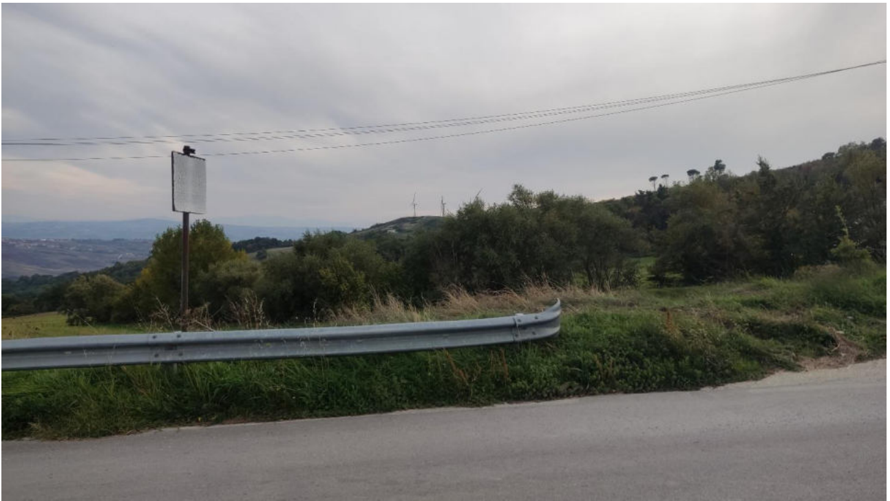
Foto 13a – Punto di Presa n° 13 Stato di Fatto
