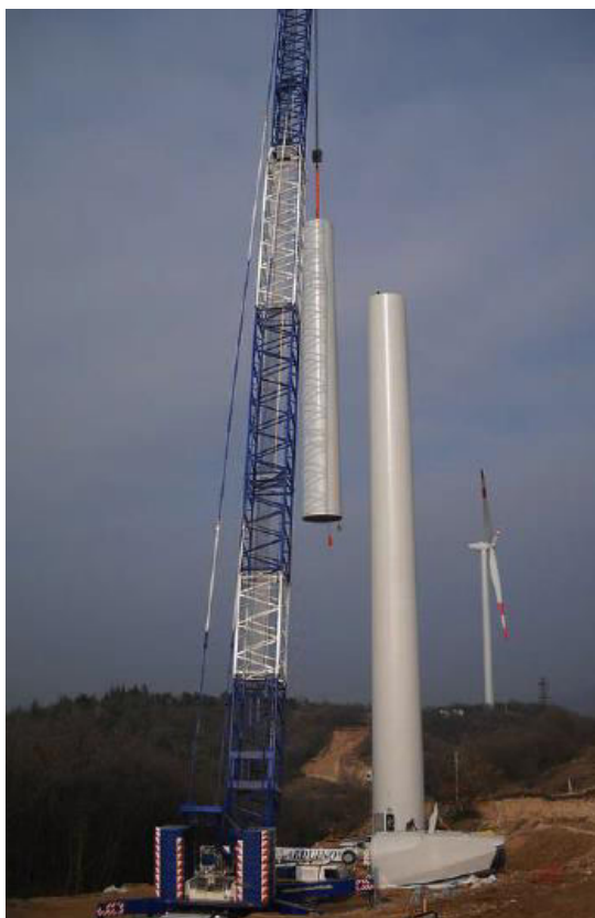
Figura 9. Operazione di montaggio di una torre eolica.
