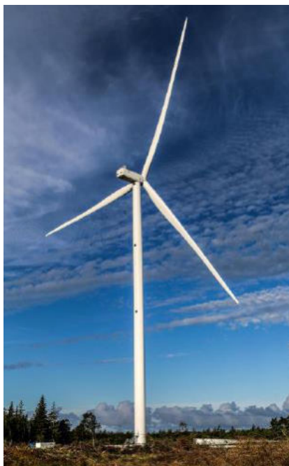
Figura 3. Aerogeneratore modello GE 158 da 6.1MW in funzione.
