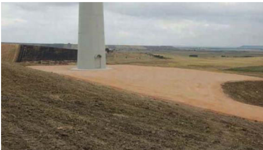
Figura 8. Sistemazione finale di una piazzola-tipo di un aerogeneratore.
