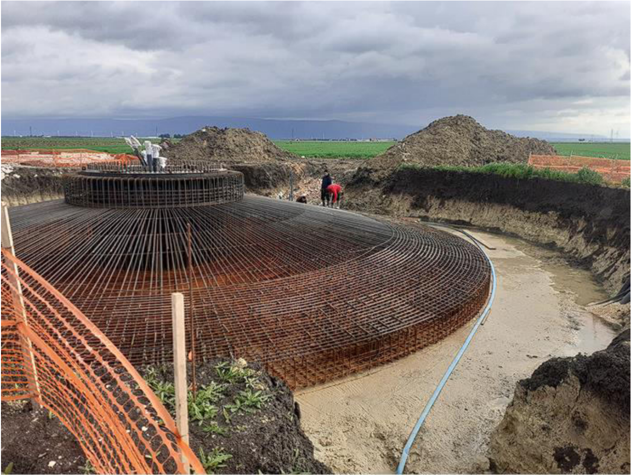
Figura 6.7. – Armatura in acciaio del plinto di fondazione.
