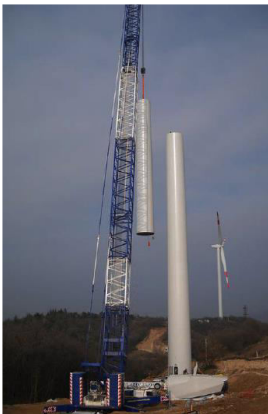
Figura 6.10. – Operazione di montaggio di una torre eolica.
