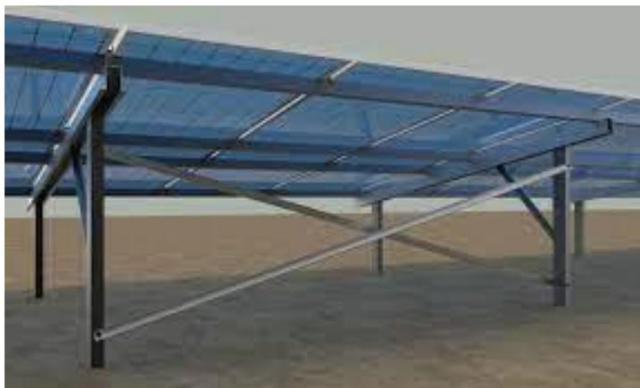
I supporti sono costituiti da telaio metallico, in acciaio zincato a caldo, costituito da pali infissi nel terreno. Non sono pertanto previste fondazioni in calcestruzzo o di tipo invasivo. Le predette strutture, saranno in grado di supportare i carichi trasmessi dai pannelli e le sollecitazioni derivanti da agenti atmosferici quali vento e neve.
