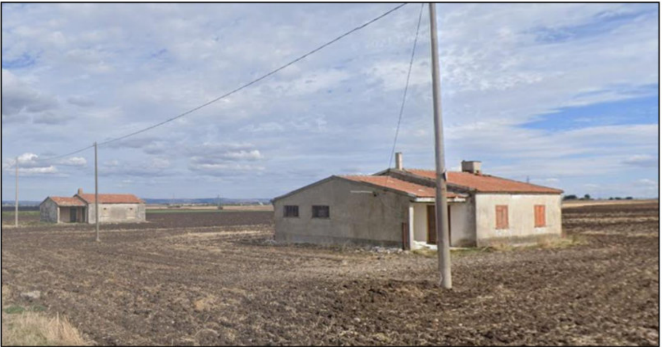
Fig.5: Abitazioni in evidente stato di abbandono e degrado nei pressi dell'area in cui sorgerà l'impianto FV
