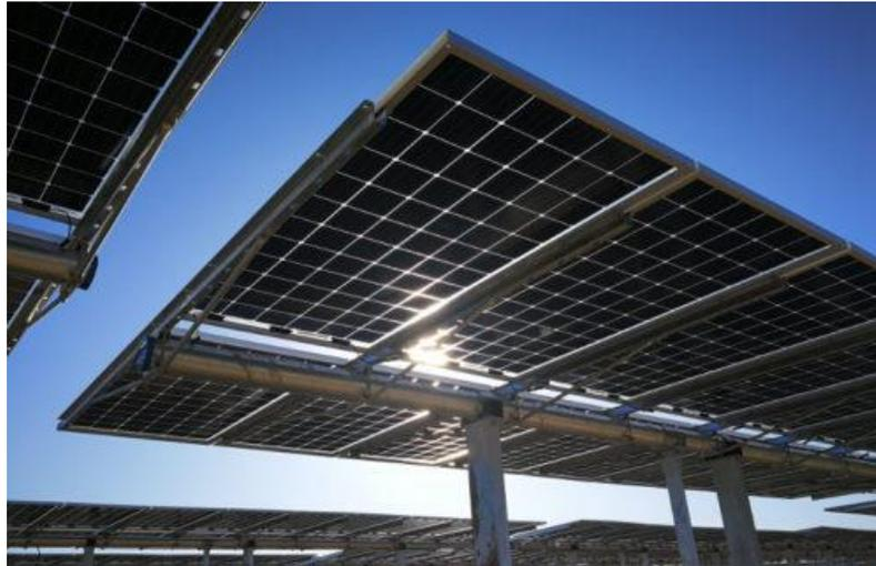
Figura 4.5 Esempio di struttura a tracker monoassiale
