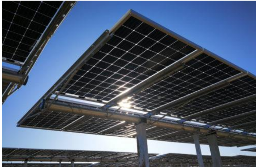
Figura 3.1: Esempio di struttura a tracker monoassiale.
