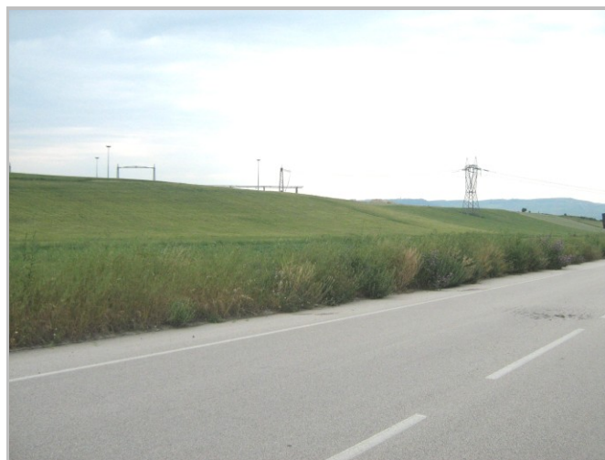
Foto 2: La stazione elettrica di Deliceto (FG) dalla SR 1
