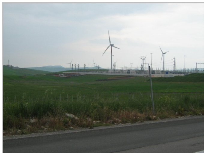
Foto 1: La stazione elettrica di Bisaccia (AV), nei pressi della SS 91
