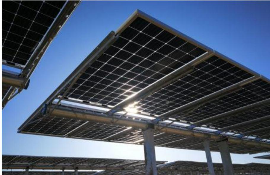
*Figura 2.8: Esempio di struttura a tracker monoassiale*
