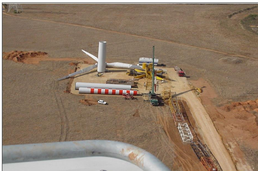
Foto 1. Piazzola per il montaggio dell'aerogeneratore
