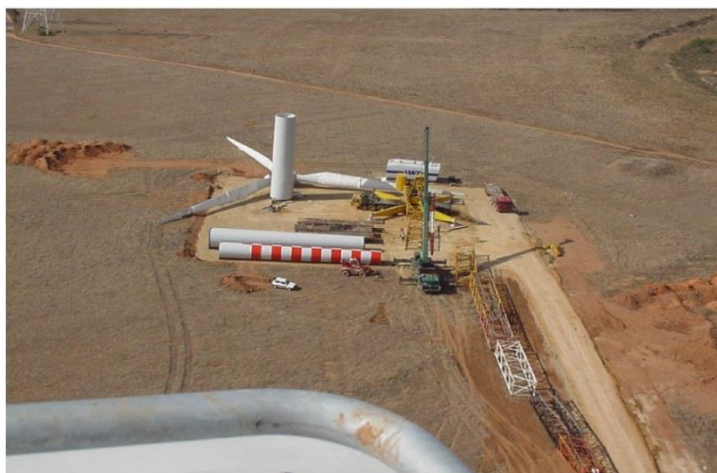
Figura 2 – Piazzola per il montaggio dell'aerogeneratore
