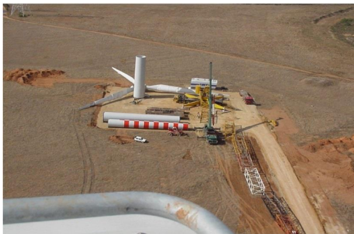
Figura 3 – Piazzola per il montaggio dell'aerogeneratore
