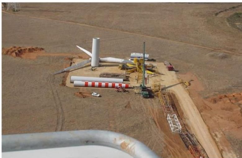
Figura 45 – Piazzola per il montaggio dell'aerogeneratore
