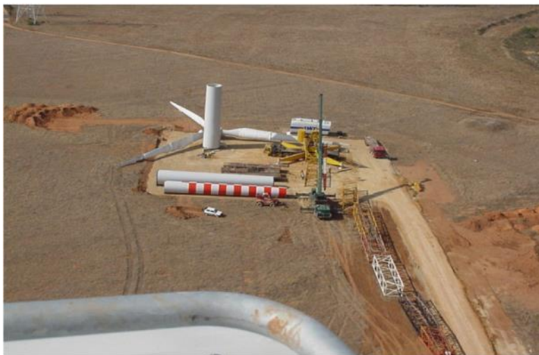
Figura 4 – Piazzola per il montaggio dell'aerogeneratore
