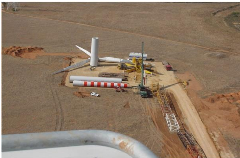
Figura 12 – Piazzola per il montaggio dell'aerogeneratore
