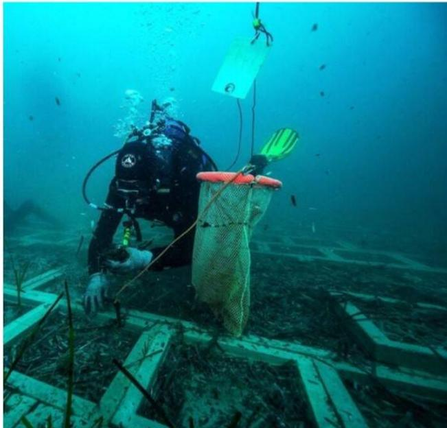
**Figura 3.13 – Esempio di utilizzo di materassi zavorrati per interventi di reimpianto di Posidonia oceanica.**
