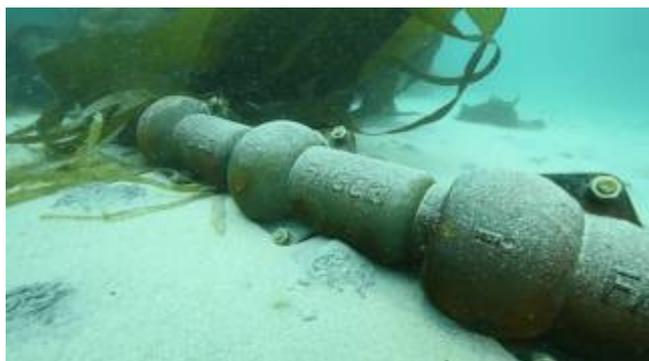
**Figura 3.15 – Esempio di posa con protezione in elementi modulari tubolari.**
