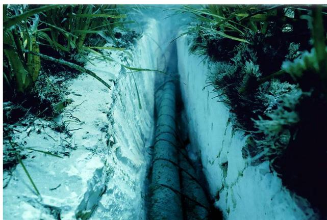
**Figura 3.9 – Esempio di posa con tecnica di trenching chirurgico.**
