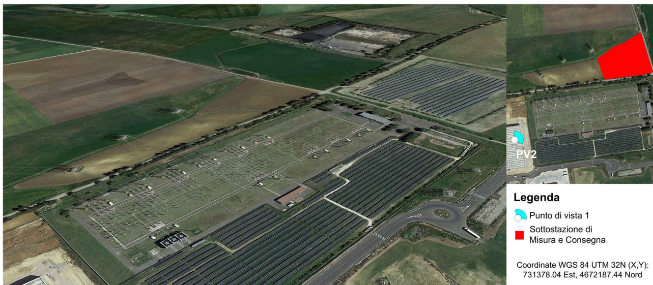
Figura 5.22 – Punto di vista (PV2) area della sottostazione di misura e consegna (ante-operam).
