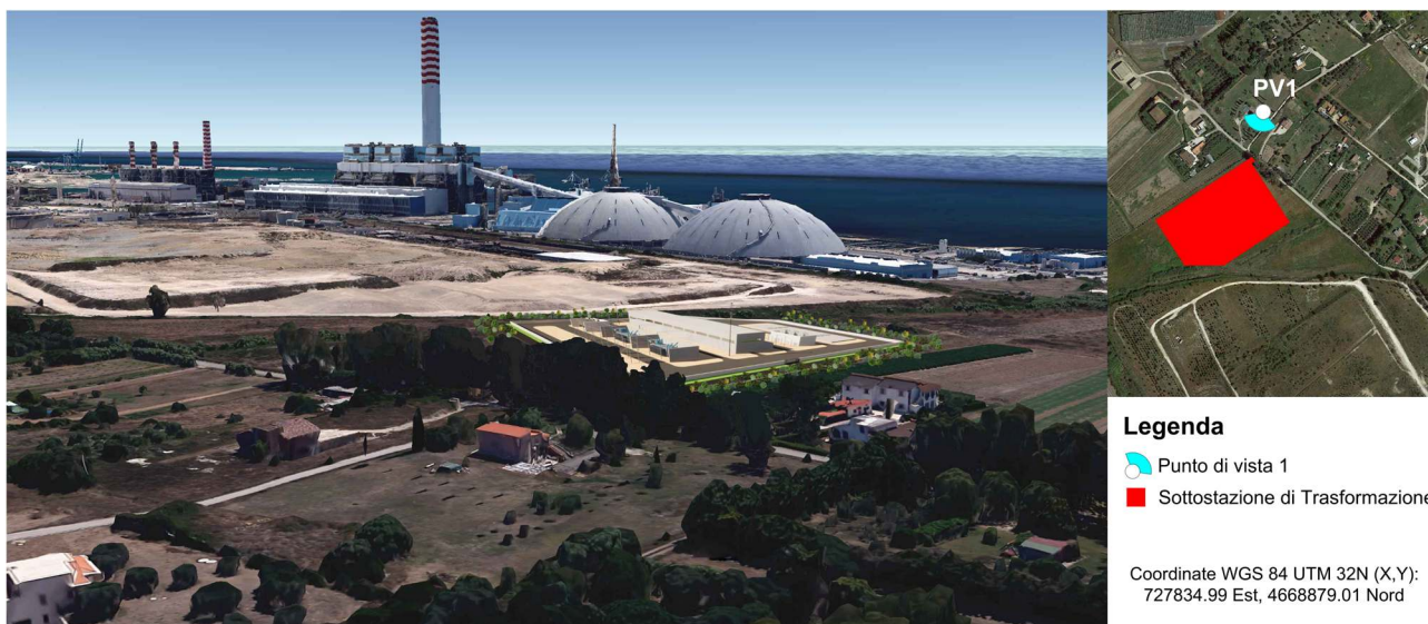
Figura 5.21 – Punto di vista (PV1) area della sottostazione di trasformazione (post-operam).
