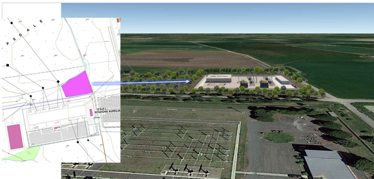
Figura 7.2 – Sottostazione di misura e consegna. Fotoinserimento con mascheramento a verde. Elaborazione iLStudio.
