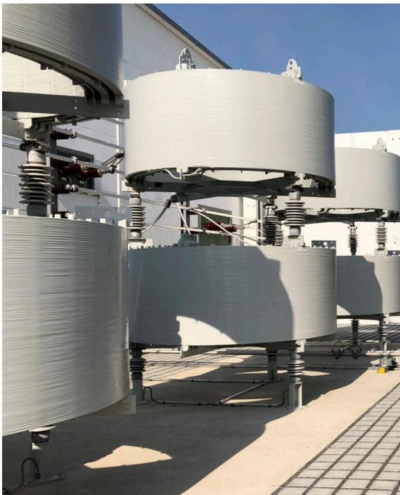
**Figura 3.12 – Compensazione reattiva - sottostazione trasformazione e consegna.**
