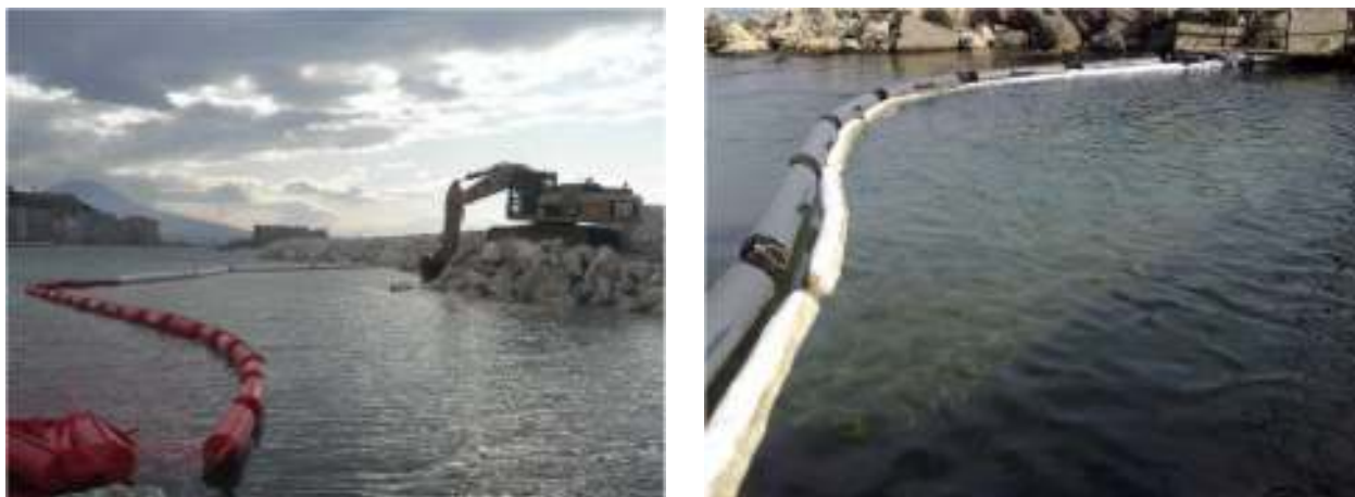
Figura 3.14 – Misure anti-intorbidimento per il confinamento delle aree di lavoro a mare.
