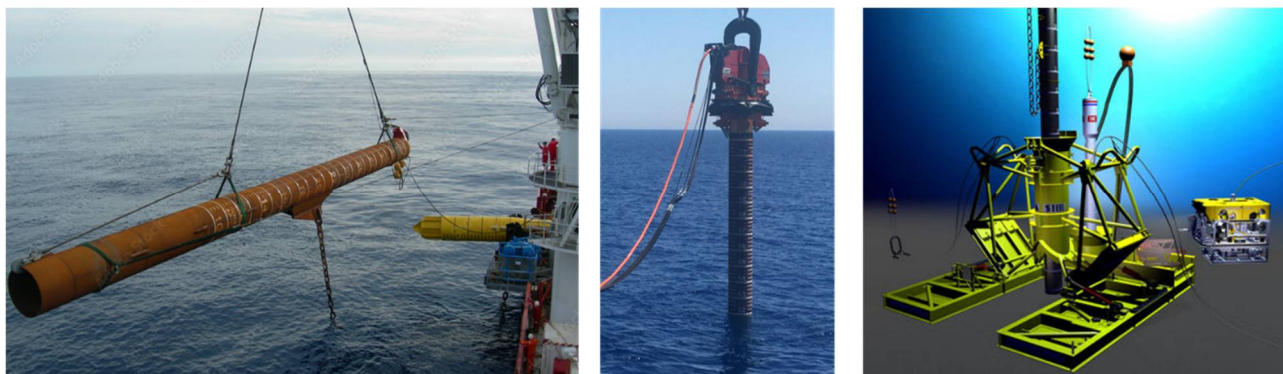
Figura 6.5 – Ancoraggio a palo infisso.
