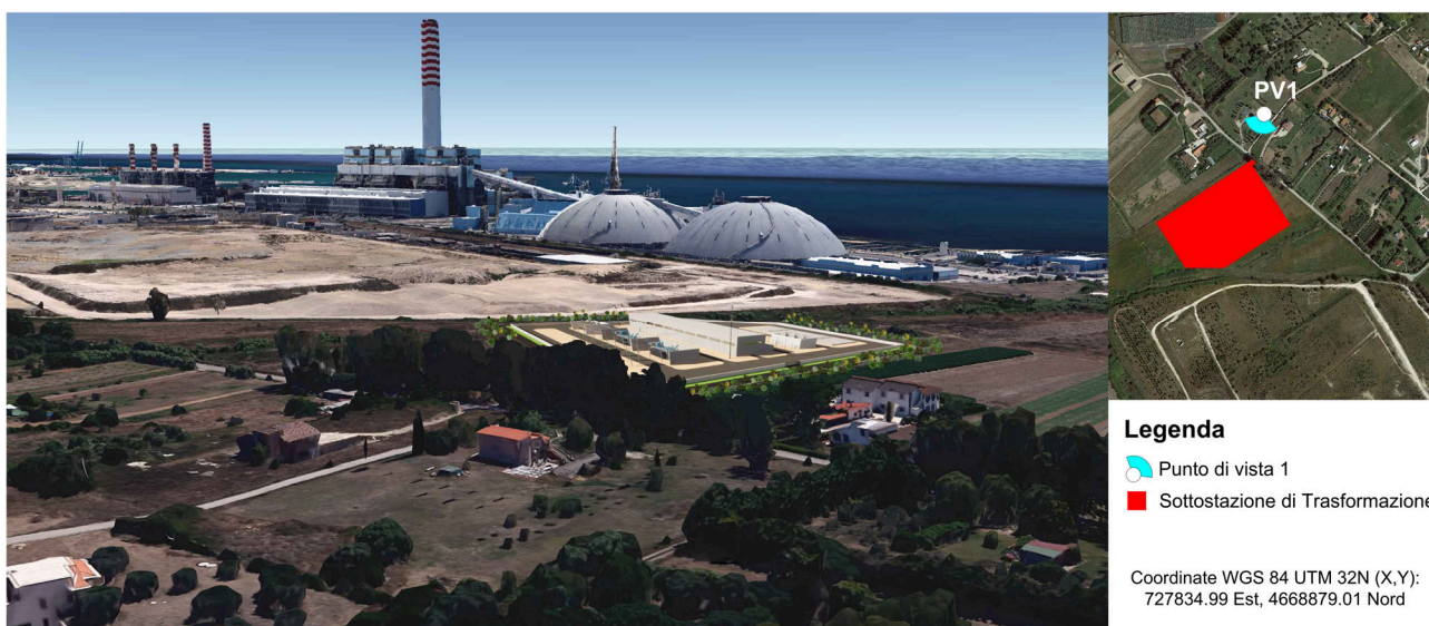
Figura 6.16 – Fotoinserimento della sottostazione di trasformazione (post-operam).
