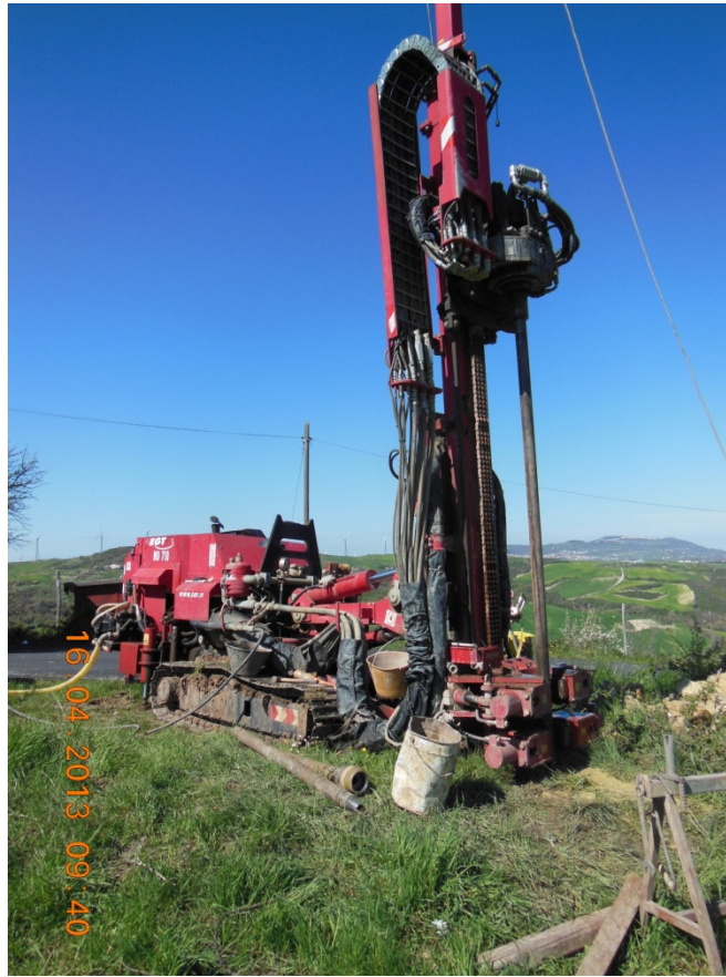
Foto 1: ubicazione sondaggio S2
