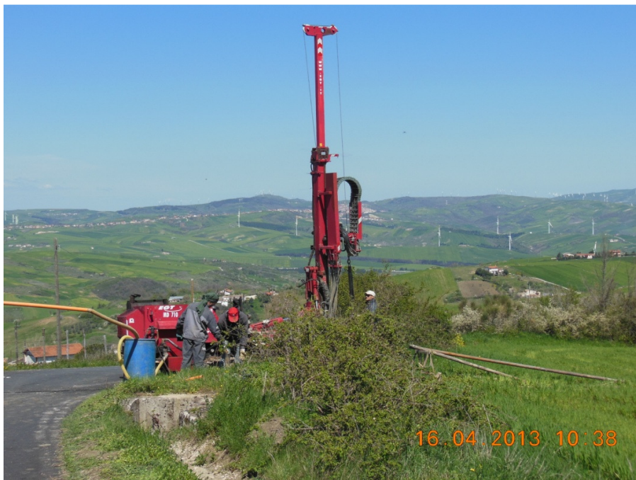
Foto 2: ubicazione sondaggio S2
