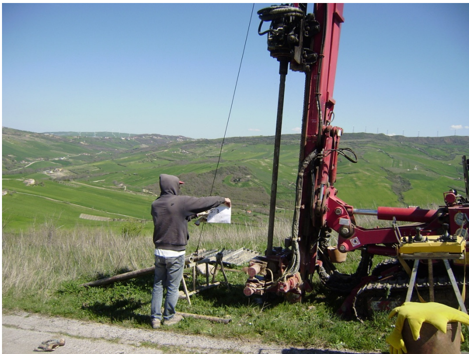
Foto 2: ubicazione sondaggio S3
