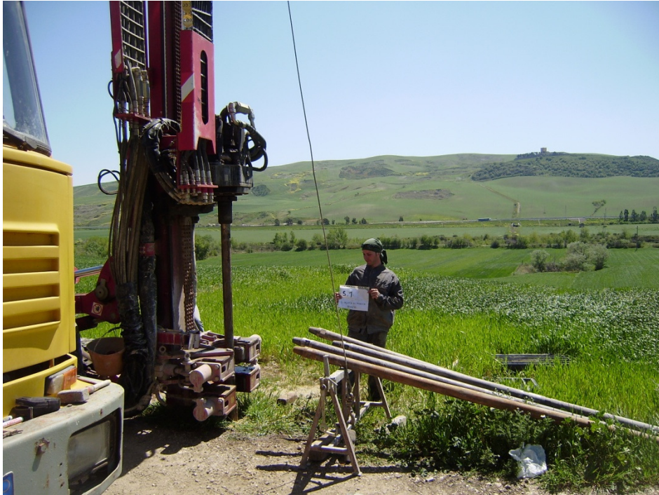
Foto 1: ubicazione sondaggio S4
