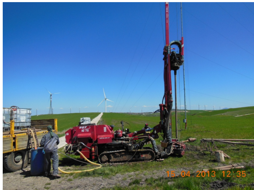
Foto 2: ubicazione sondaggio S1
