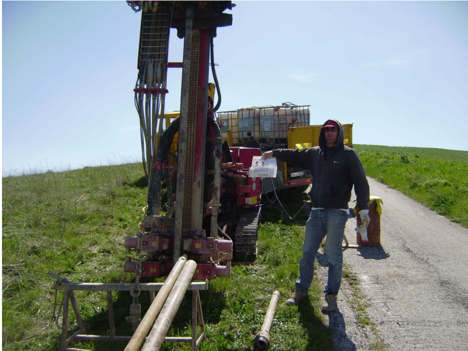
Foto 1: ubicazione sondaggio S3
