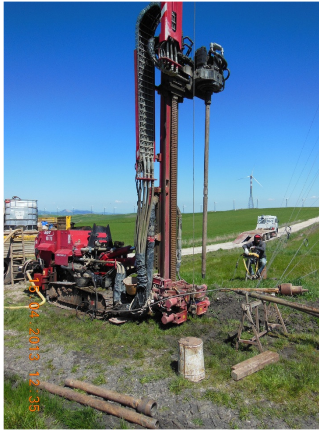
Foto 1: ubicazione sondaggio S1
