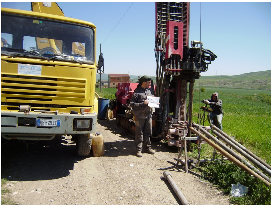
Foto 2: ubicazione sondaggio S4
