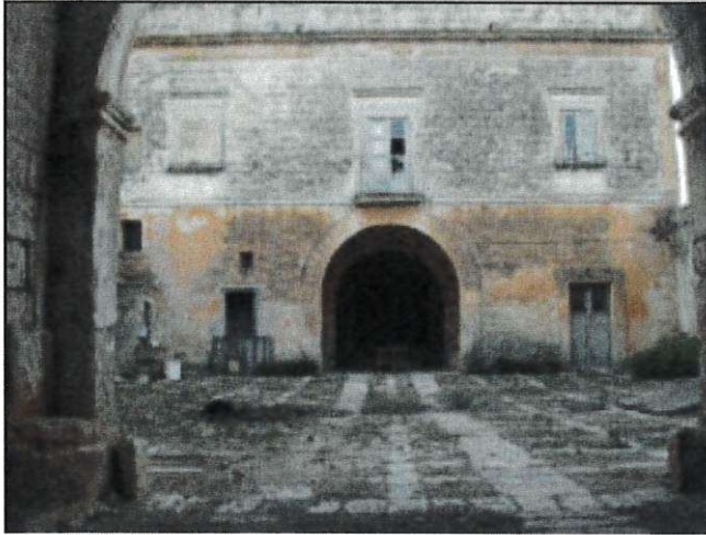
Figura 5 – Baglio in C.da Ghelbi Minore, immagine tratta da schede beni isolati allegate al PP. di Trapani
