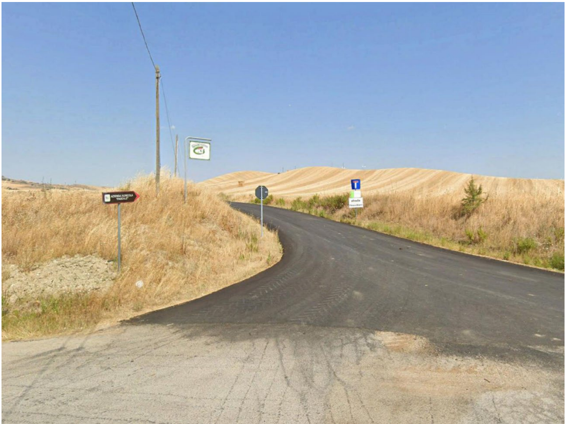
Foto 10a – Punto di Presa n° 10 Stato di Fatto
