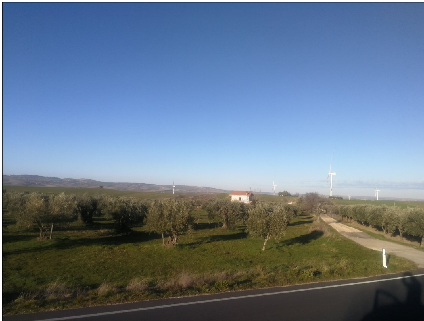
Figura 43 - Area d'installazione impianto
