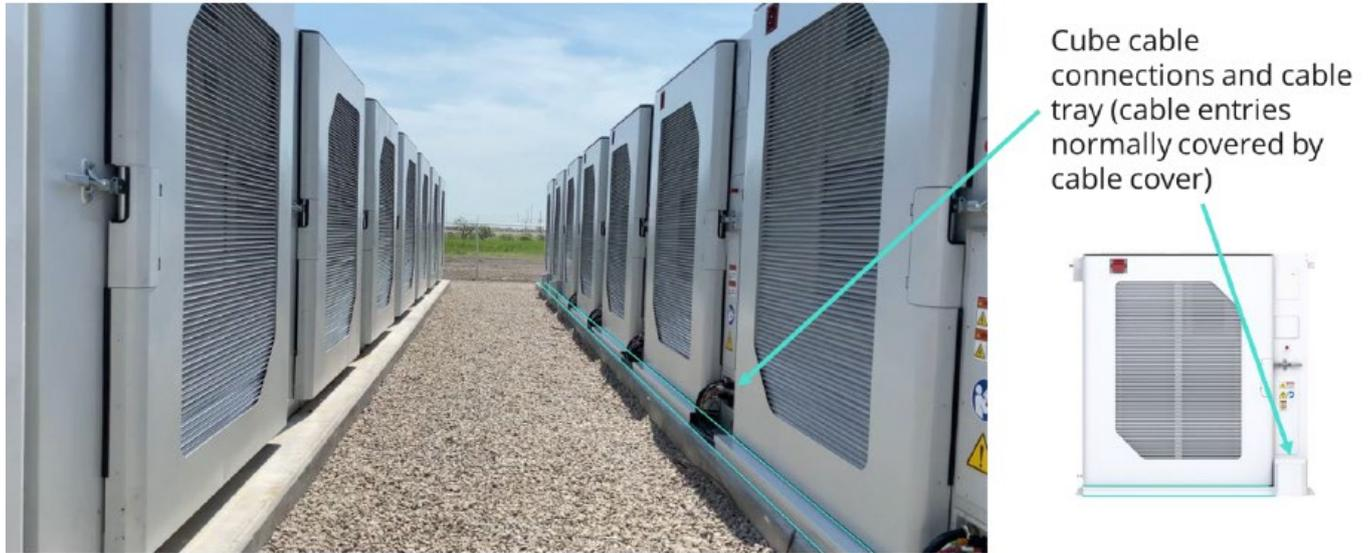
**Figura 31: esempio di dispositivo portacavi**
