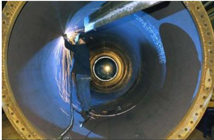
Figura 17: interno di una torre
