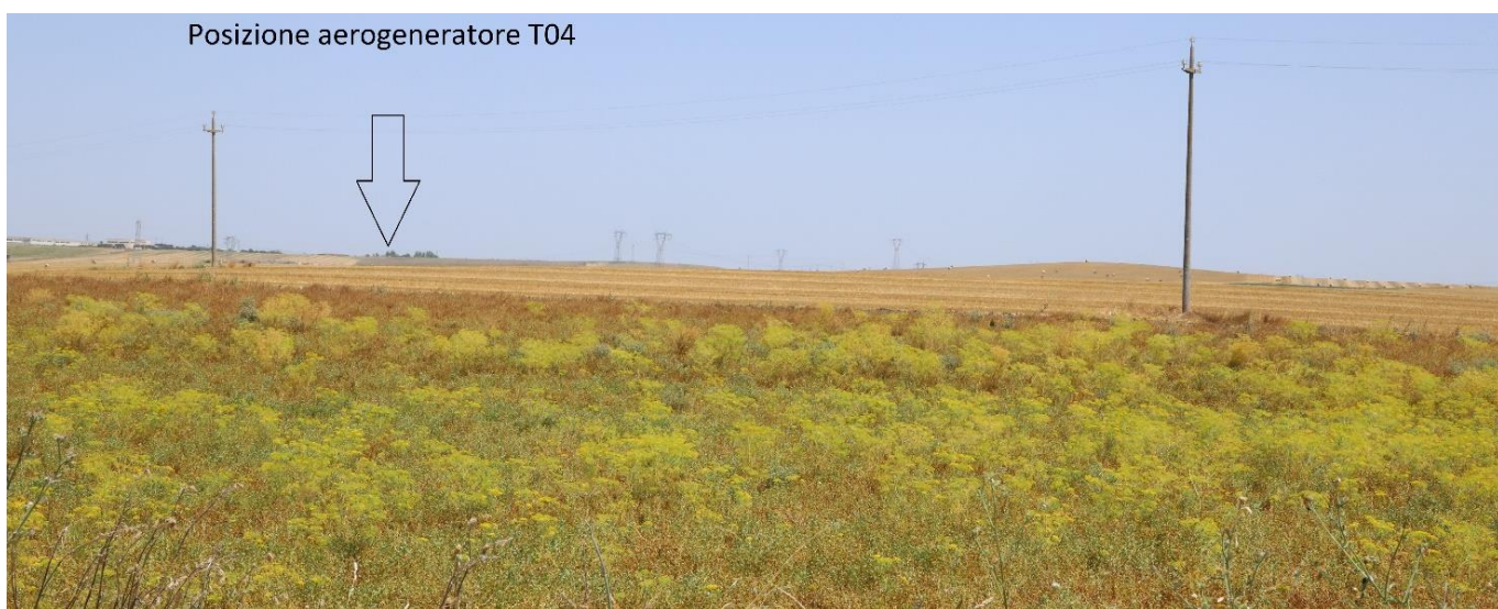
Figura 25 panoramica dell'area interessata dalle opere per la realizzazione dell'aerogeneratore T04
