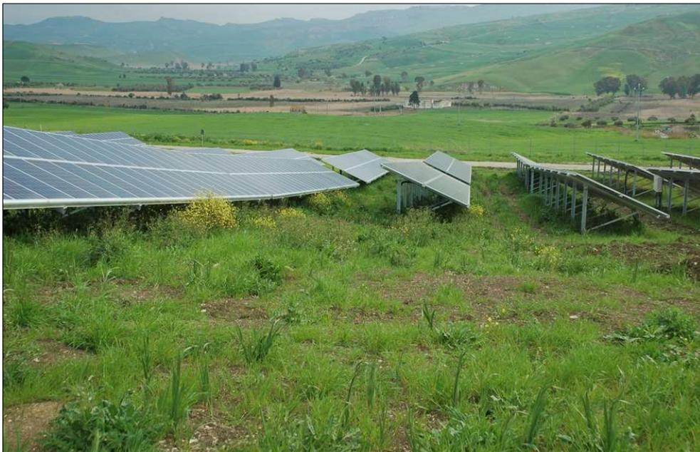
*Figura 23. Esempio reale di impianto fotovoltaico con crescita di vegetazione sotto il pannello*
