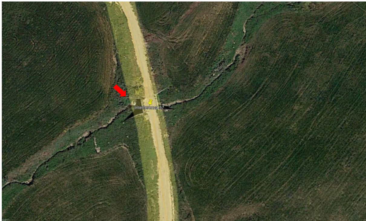
Figura 123. Ortofoto attraversamento con scatolare in cls su reticolo idrografico
