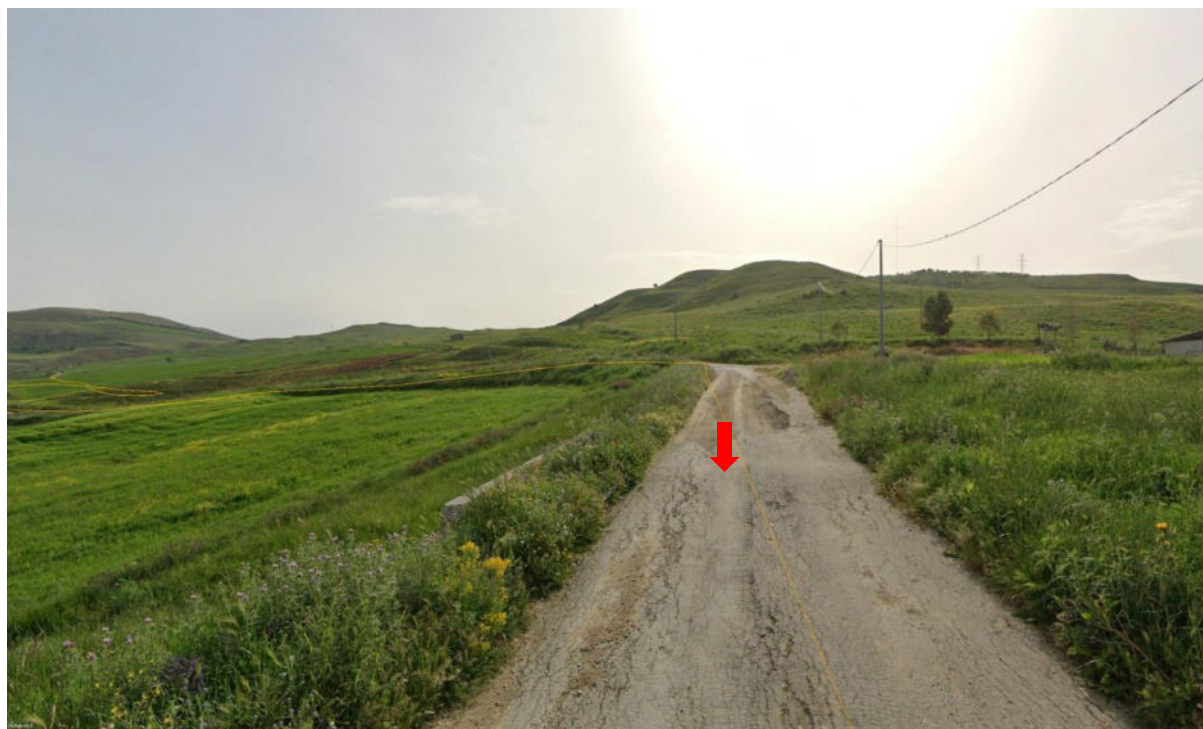
Figura 142. Vista attraversamento con scatolare in cls
