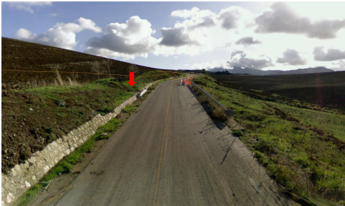
Figura 92. Vista attraversamento con scatolare in cls
