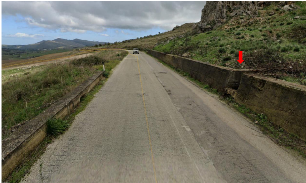
Figura 180. Vista attraversamento con scatolare in cls
