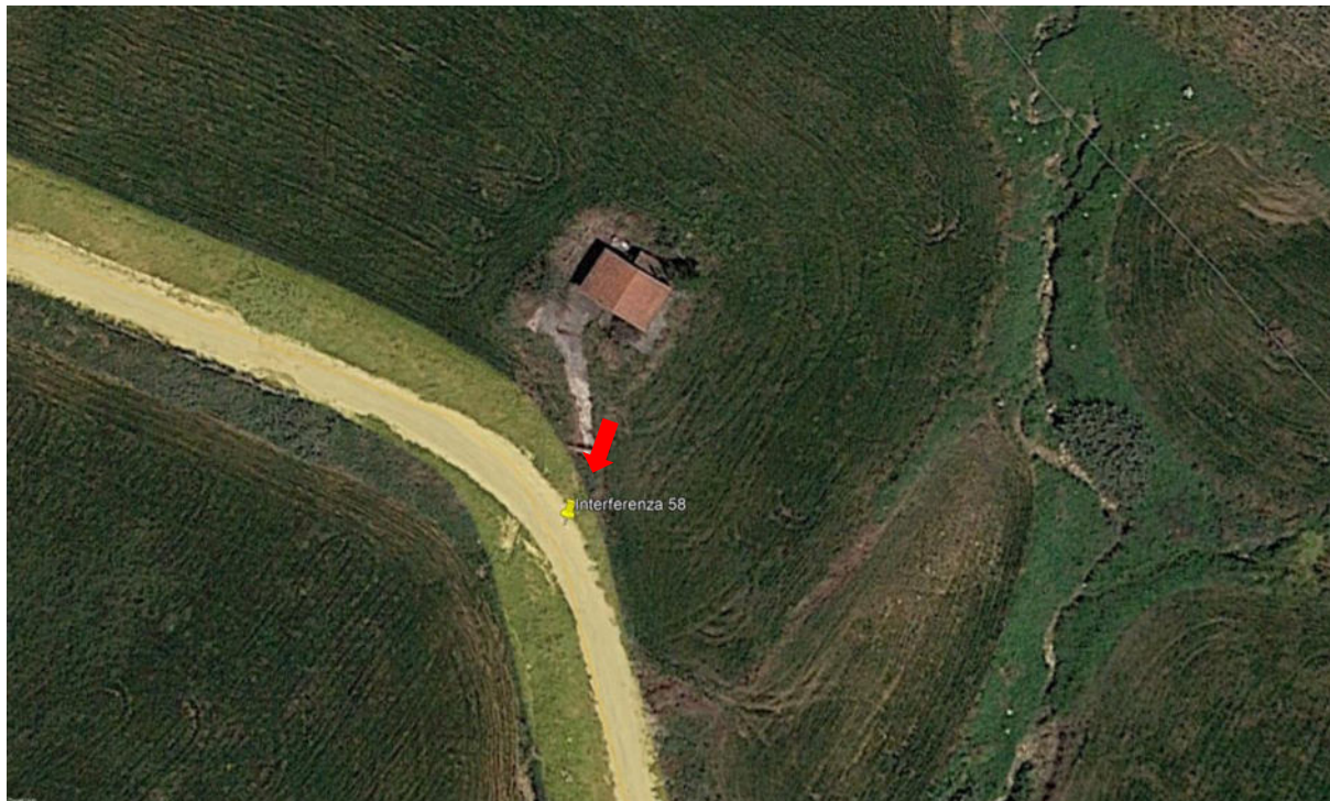
Figura 125. Ortofoto attraversamento con scatolare in cls
