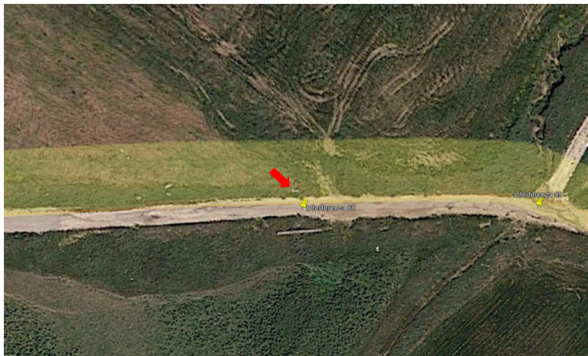
Figura 129. Ortofoto attraversamento con scatolare in cls
