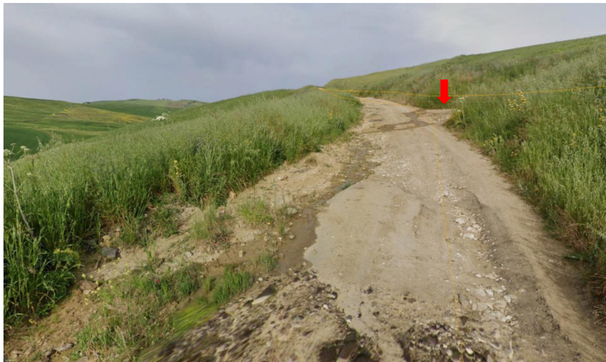
Figura 128. Vista attraversamento con scatolare in cls
