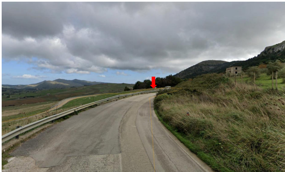
Figura 186. Vista attraversamento con scatolare in cls
