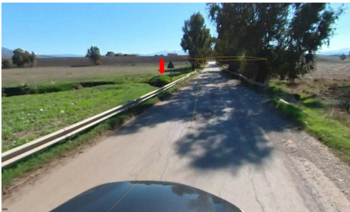
Figura 16. Vista attraversamento con scatolare in cls su reticolo idrografico
