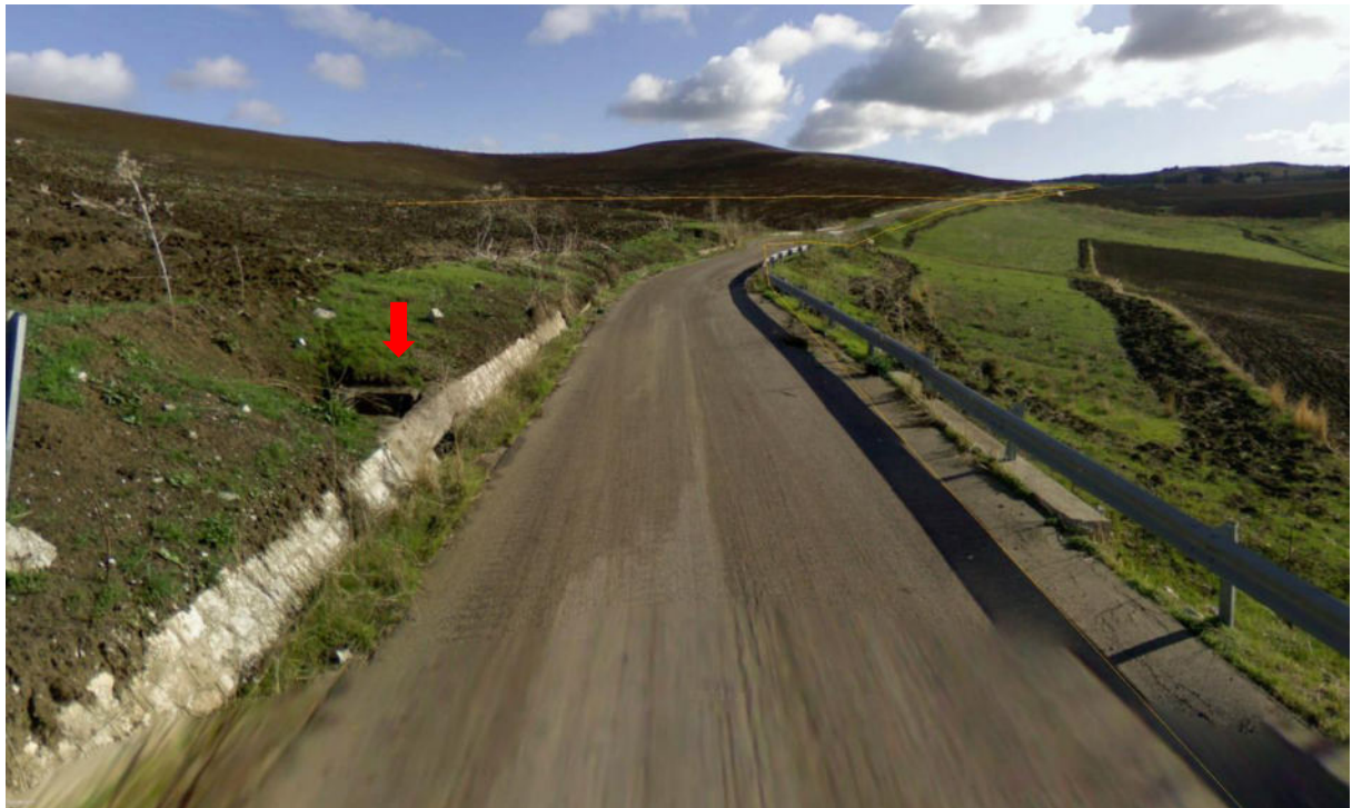
Figura 88. Vista attraversamento con scatolare in cls
