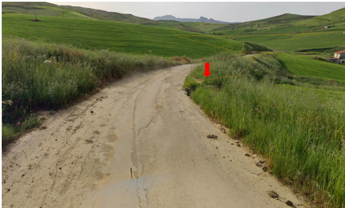
Figura 126. Vista attraversamento con scatolare in cls
