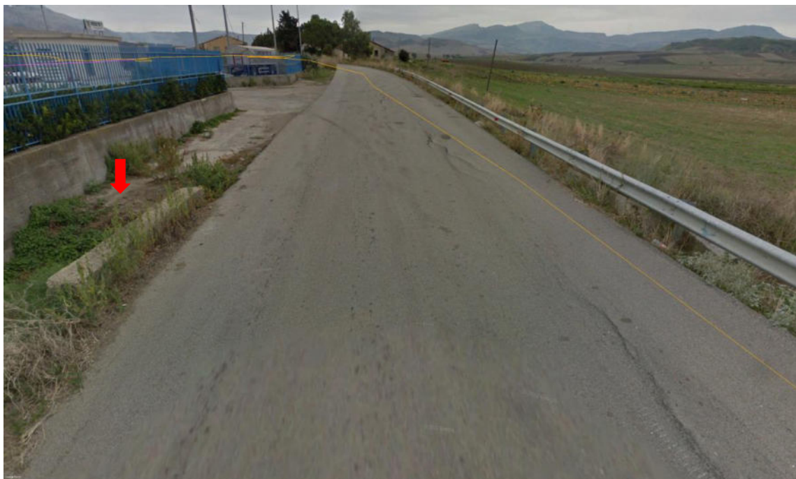
Figura 26. Vista attraversamento con scatolare in cls
