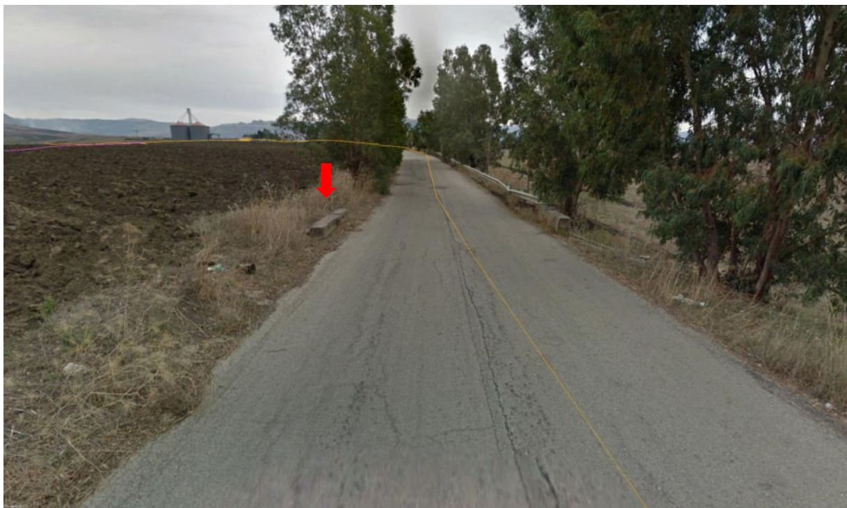
Figura 24. Vista attraversamento con scatolare in cls
