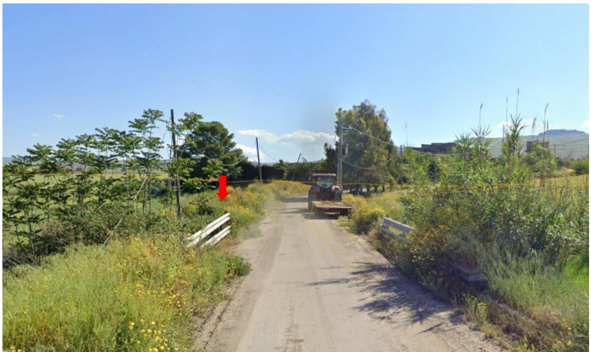
Figura 36. Vista attraversamento con scatolare in cls
