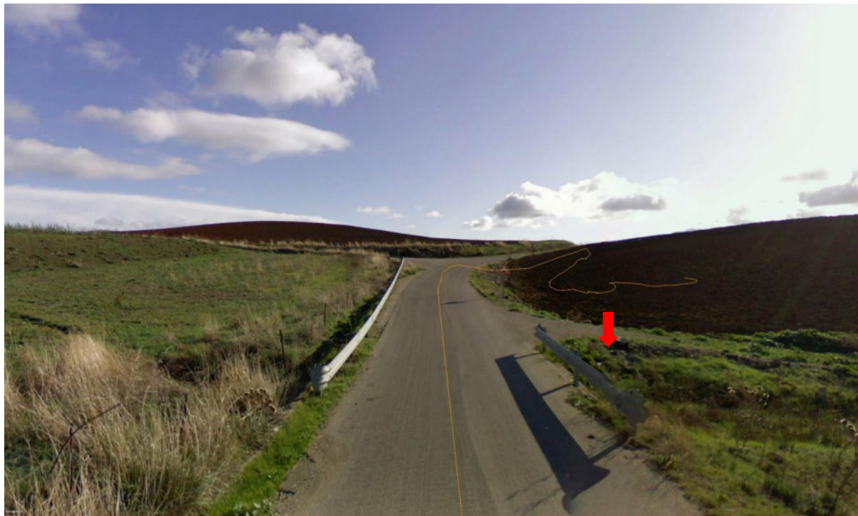
Figura 74. Vista attraversamento con scatolare in cls
