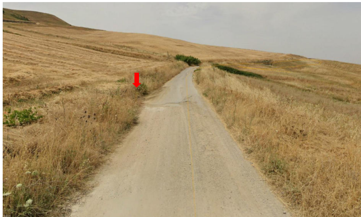
Figura 150. Vista attraversamento con scatolare in cls
