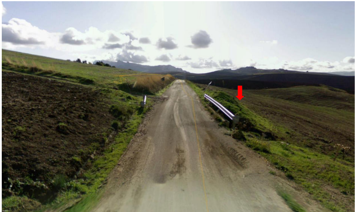
Figura 80. Vista attraversamento con scatolare in cls
