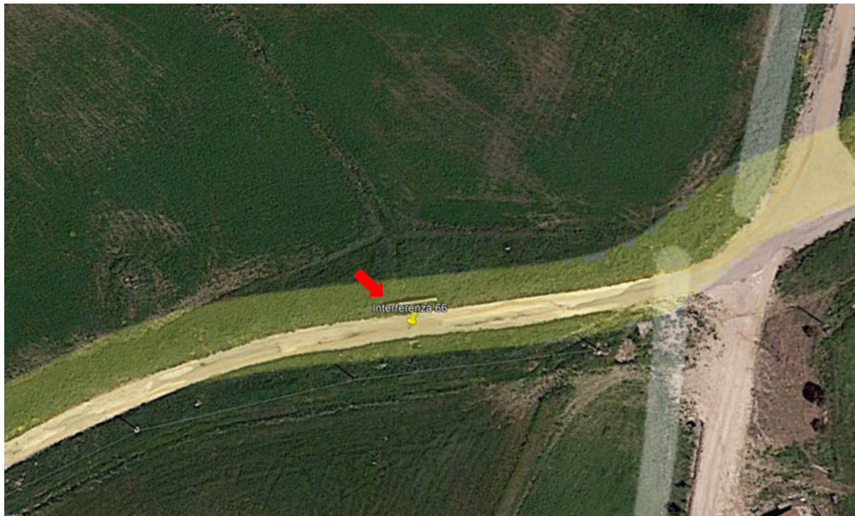
Figura 141. Ortofoto attraversamento con scatolare in cls
