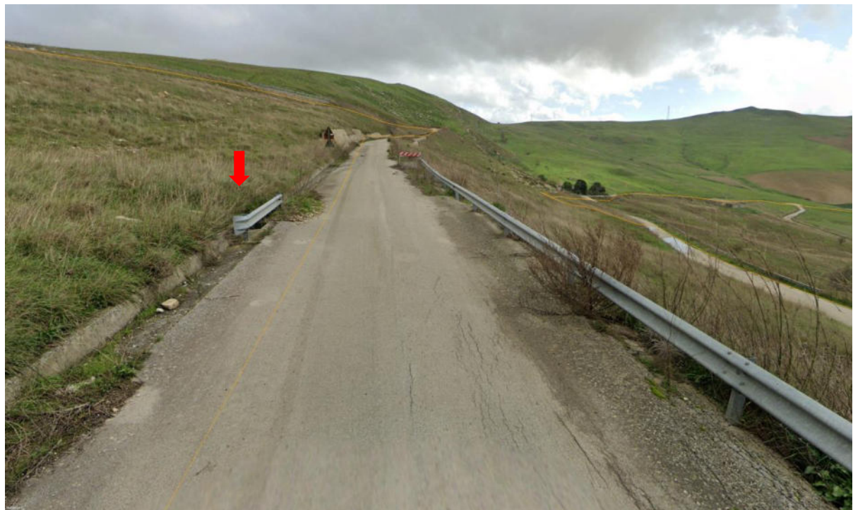
Figura 168. Vista attraversamento con scatolare in cls
