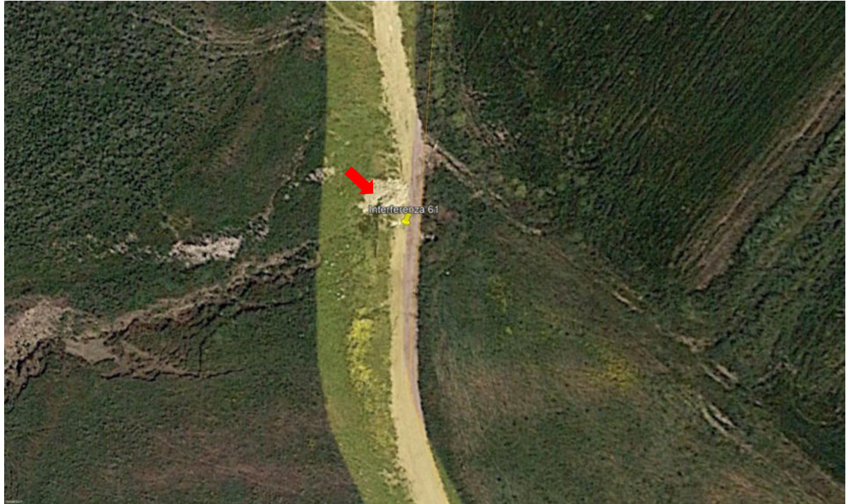
Figura 131. Ortofoto attraversamento con scatolare in cls
