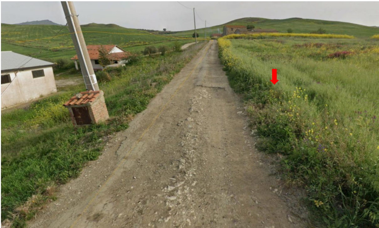
Figura 98. Vista attraversamento con scatolare in cls
