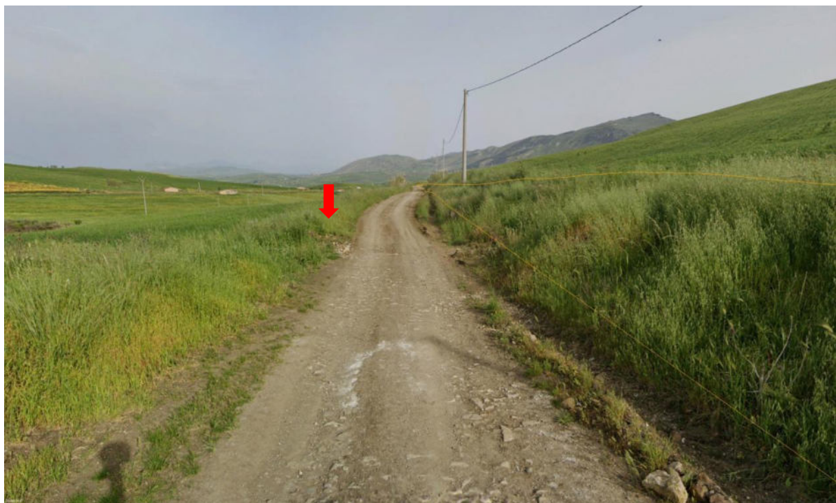
Figura 102. Vista attraversamento con scatolare in cls
