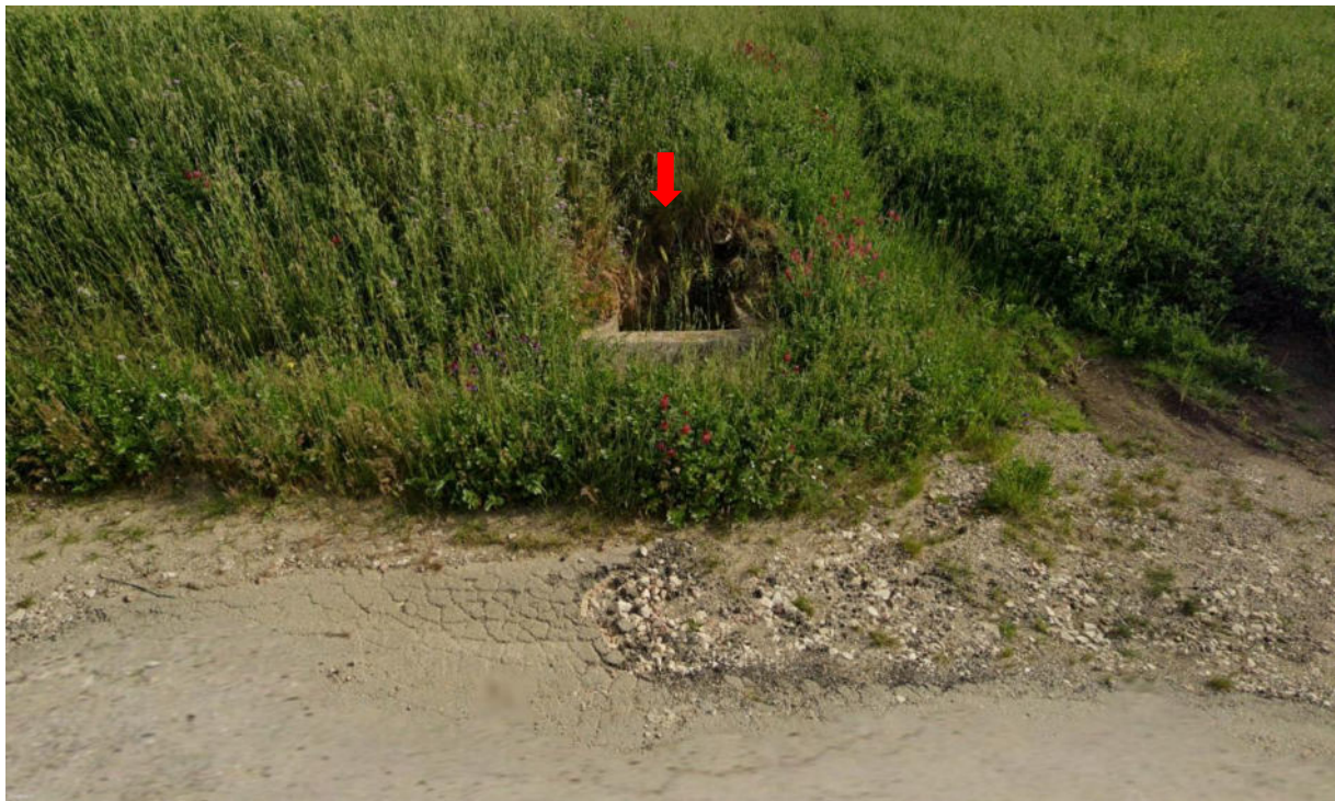
Figura 138. Vista attraversamento con scatolare in cls
