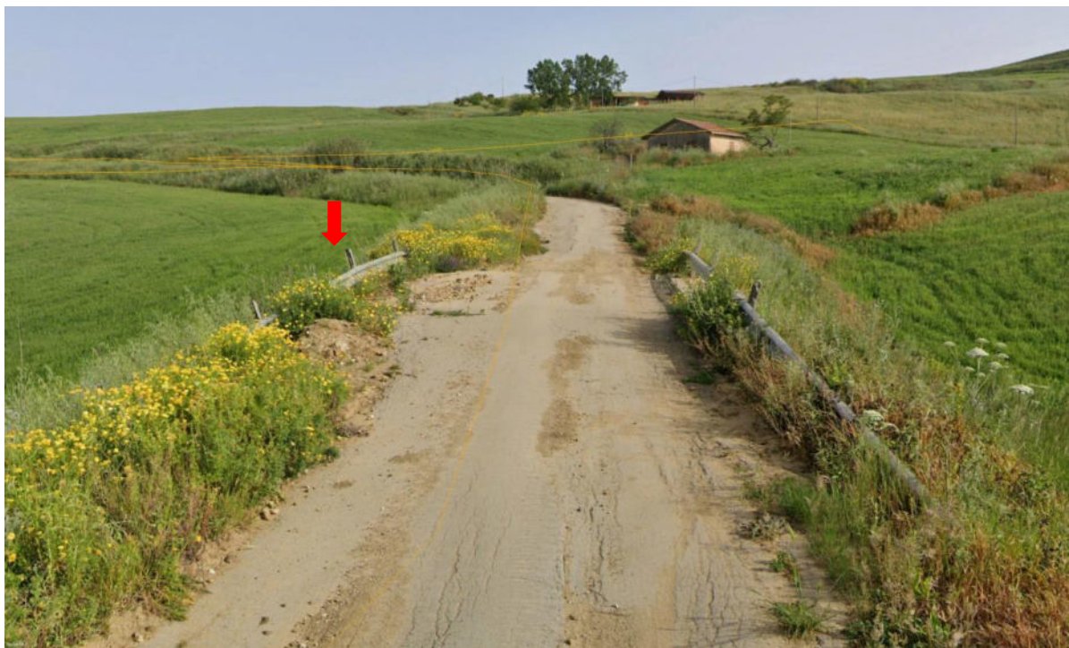
Figura 124. Vista attraversamento con scatolare in cls su reticolo idrografico
