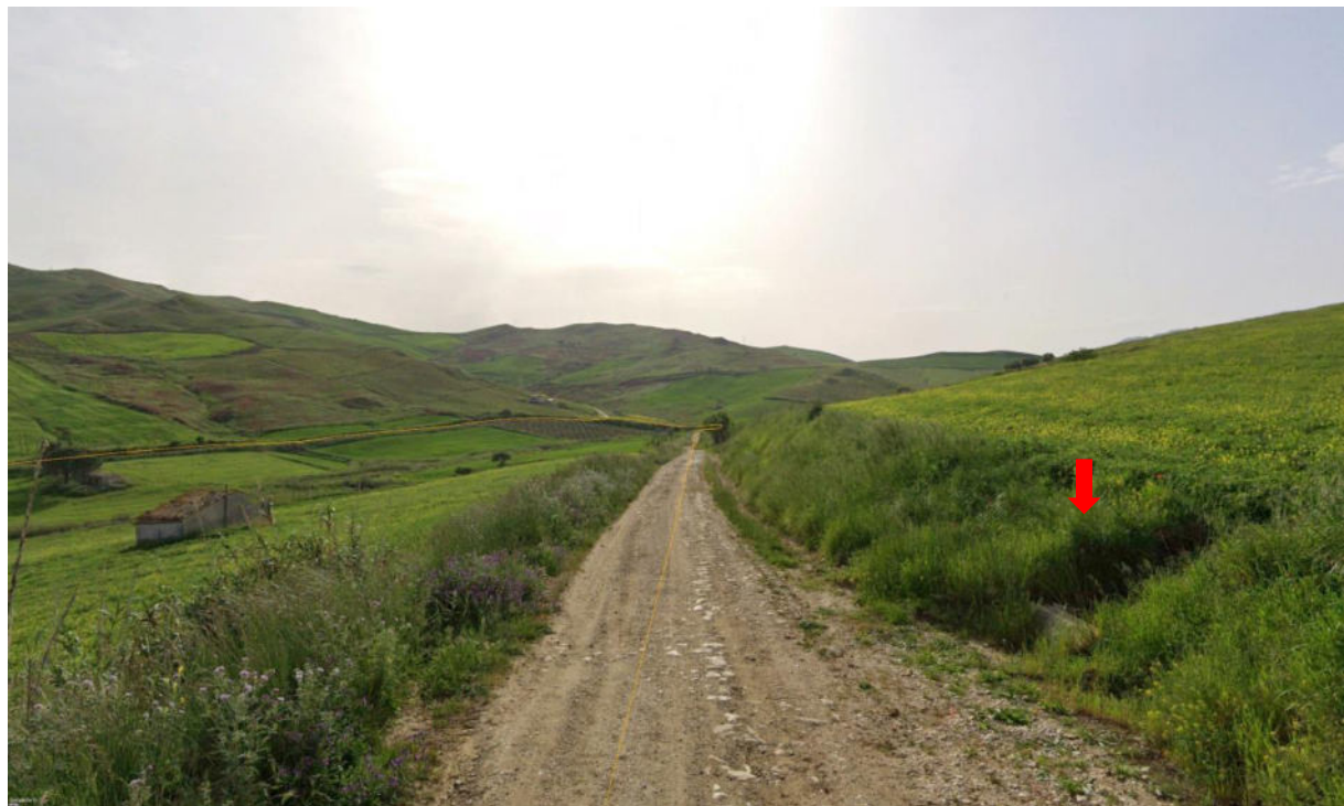
Figura 112. Vista attraversamento con scatolare in cls
