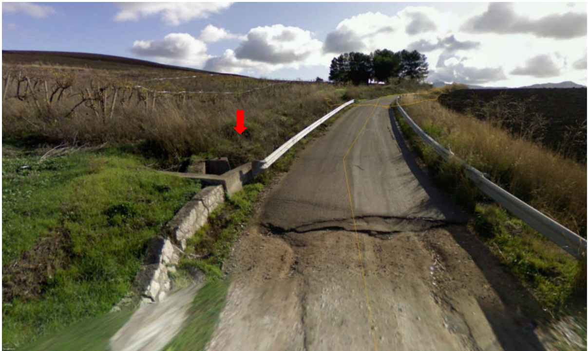
Figura 84. Vista attraversamento con scatolare in cls
