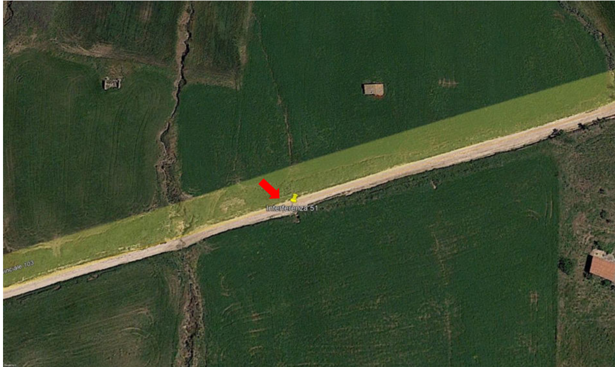
Figura 111. Ortofoto attraversamento con scatolare in cls
