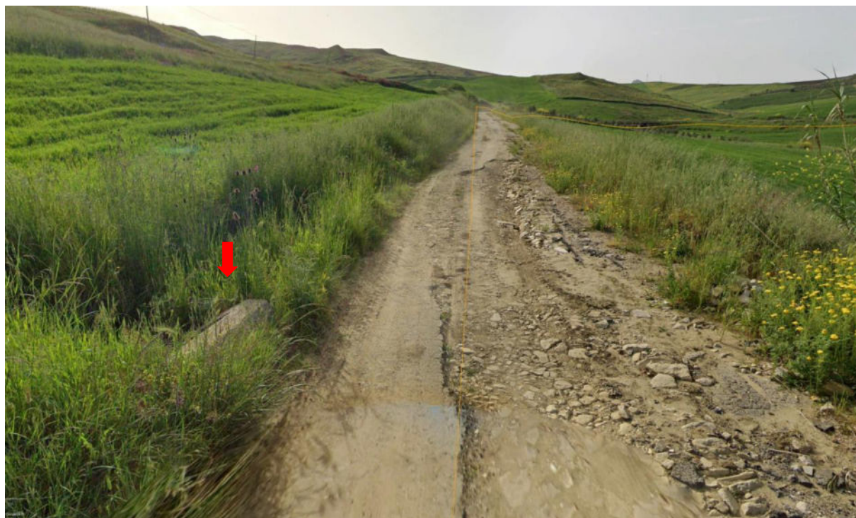
Figura 120. Vista attraversamento con scatolare in cls su reticolo idrografico
