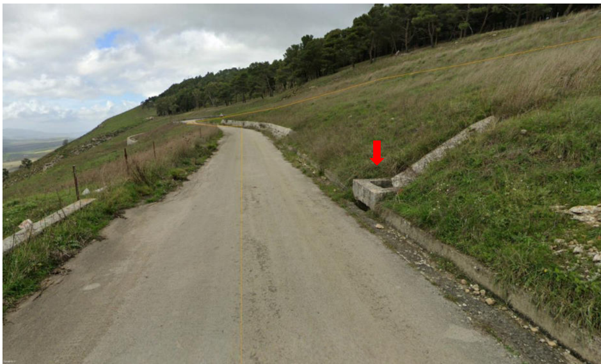
Figura 166. Vista attraversamento con scatolare in cls
