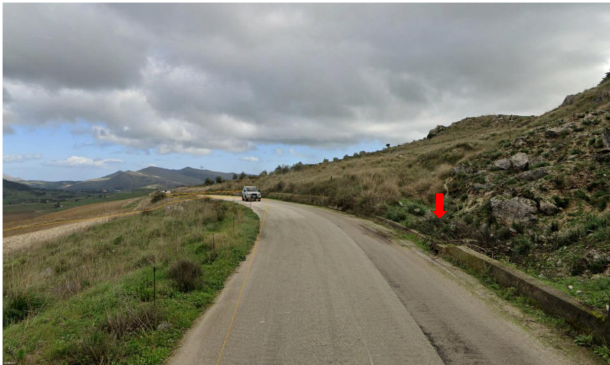
Figura 182. Vista attraversamento con scatolare in cls
