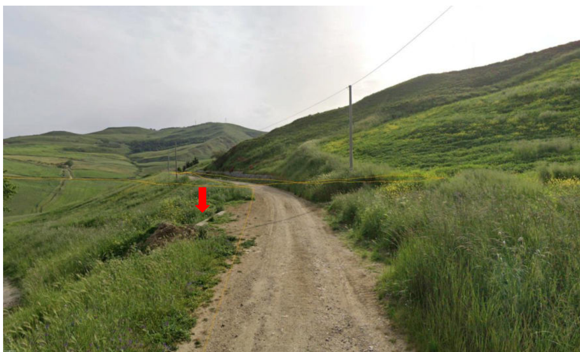
Figura 106. Vista attraversamento con scatolare in cls
