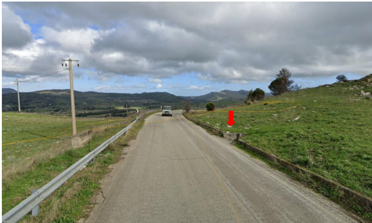
Figura 178. Vista attraversamento con scatolare in cls
