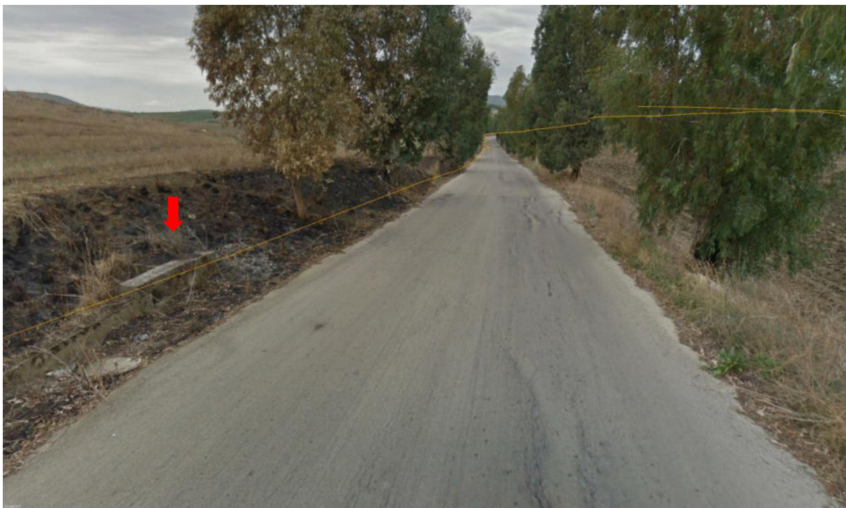
Figura 22. Vista attraversamento con scatolare in cls su reticolo idrografico
