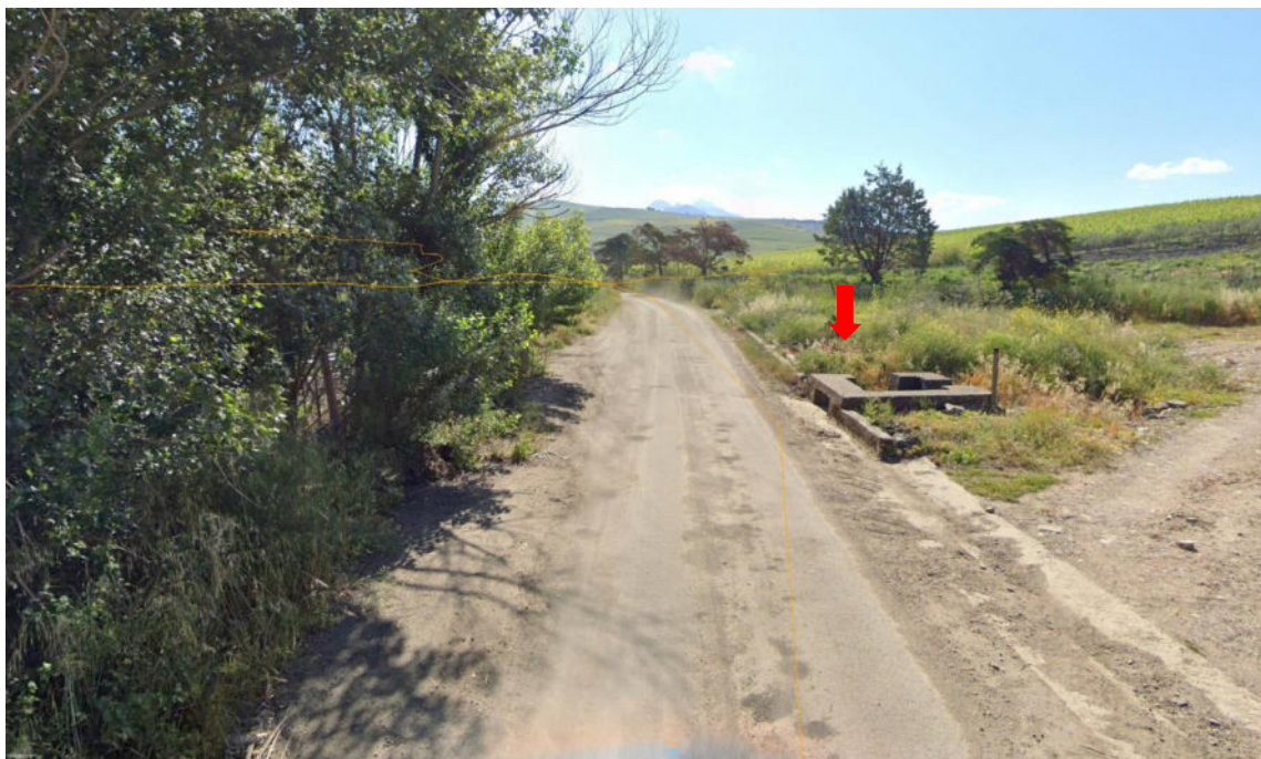
Figura 38. Vista attraversamento con scatolare in cls
