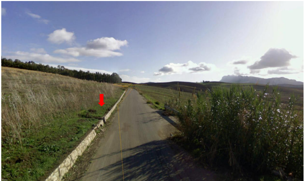
Figura 64. Vista attraversamento con scatolare in cls
