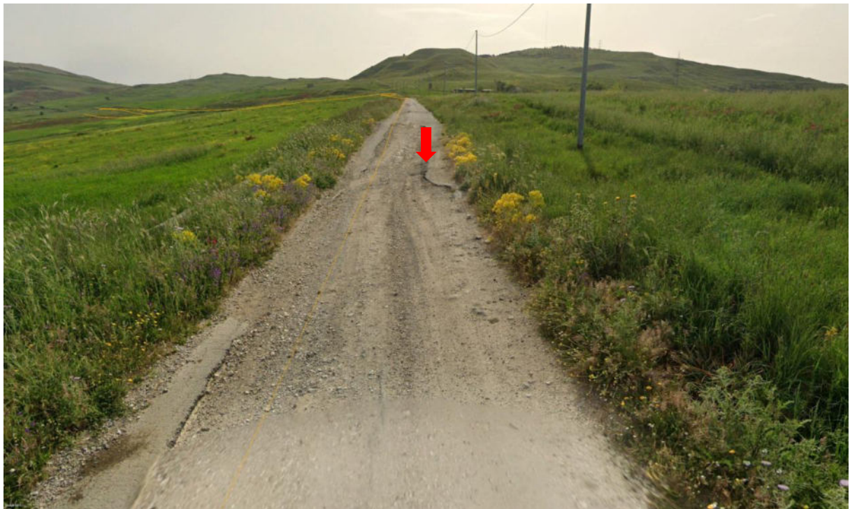
Figura 140. Vista attraversamento con scatolare in cls
