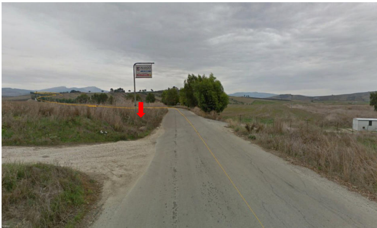
Figura 18. Vista attraversamento con scatolare in cls
