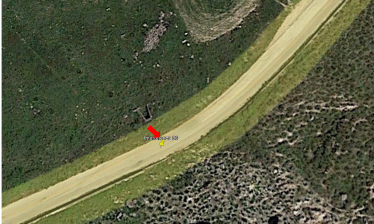
Figura 181. Ortofoto attraversamento con scatolare in cls
