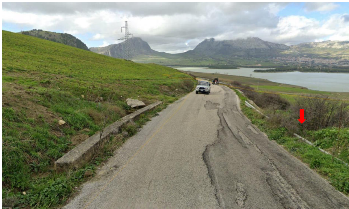
Figura 192. Vista attraversamento con scatolare in cls
