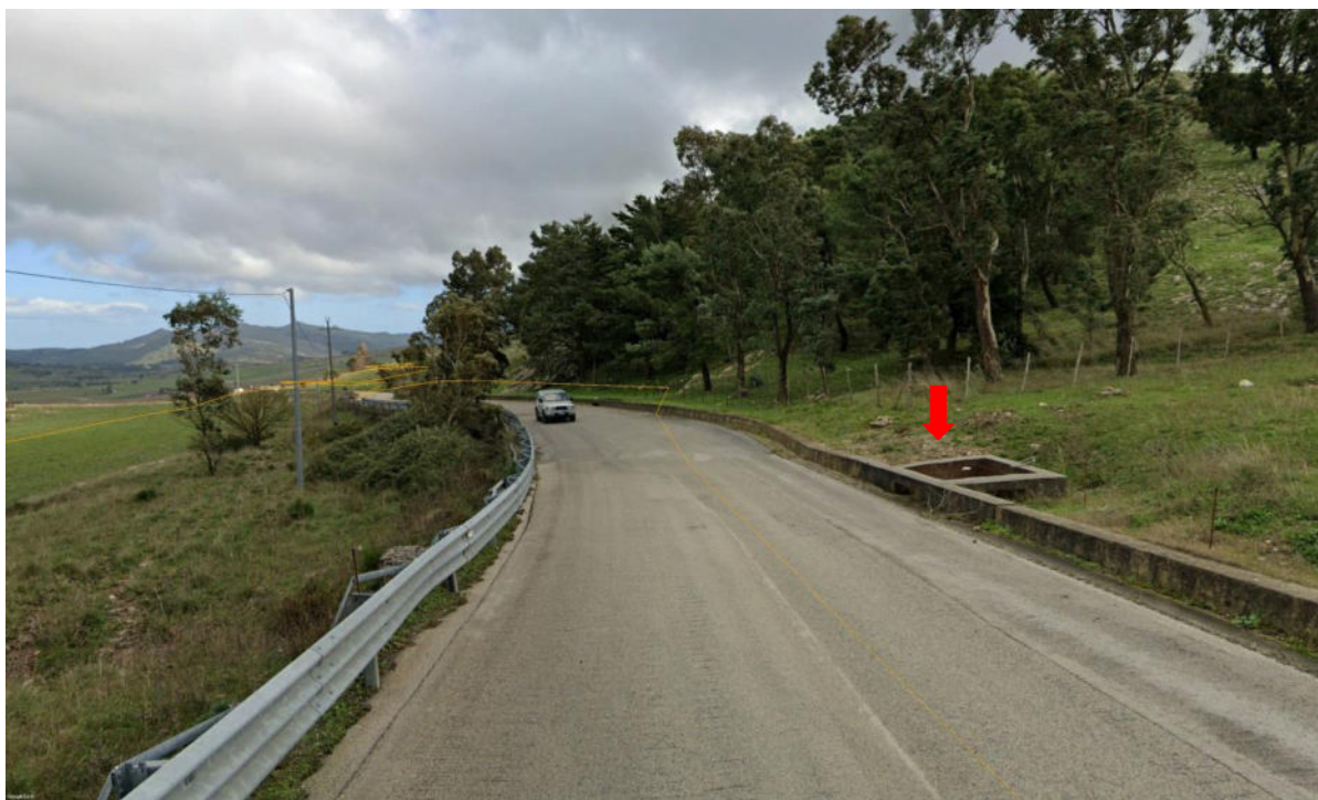
Figura 174. Vista attraversamento con scatolare in cls
