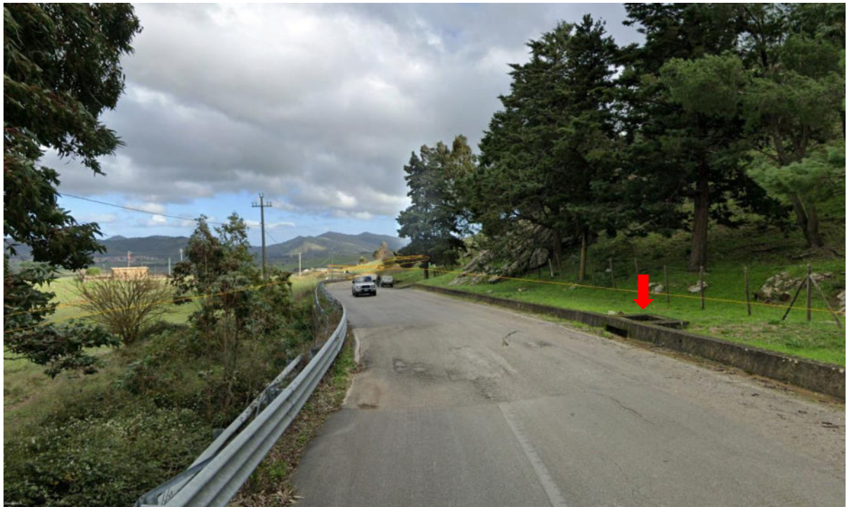
Figura 176. Vista attraversamento con scatolare in cls
