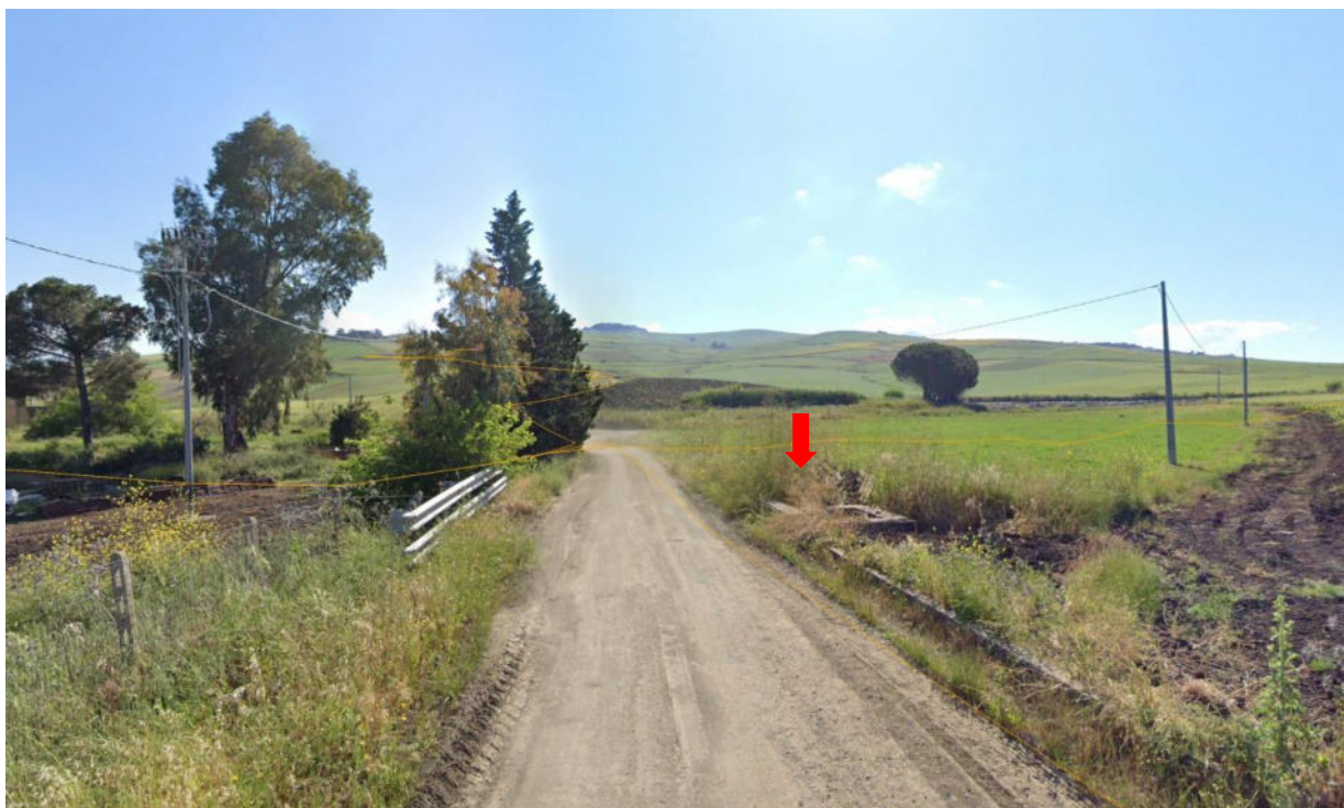
Figura 40. Vista attraversamento con scatolare in cls
