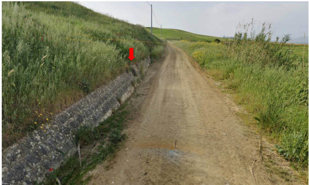
Figura 104. Vista attraversamento con scatolare in cls
