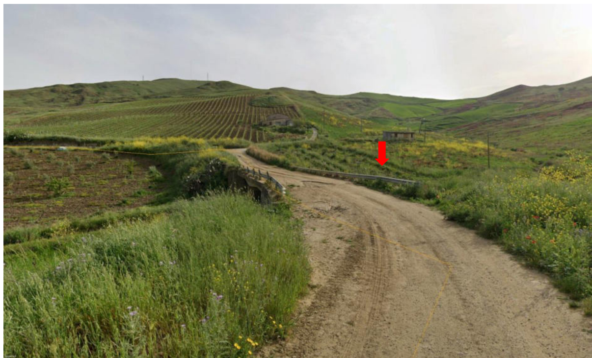
Figura 118. Vista attraversamento con scatolare in cls su reticolo idrografico
