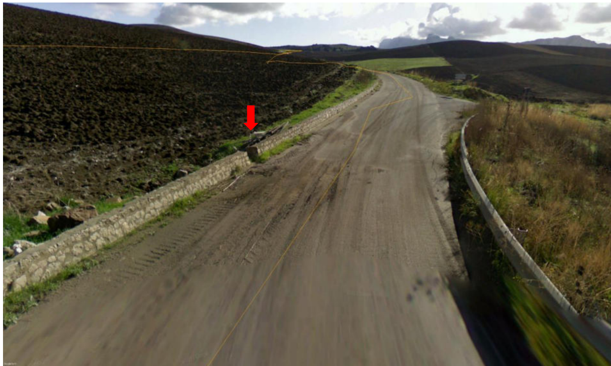
Figura 86. Vista attraversamento con scatolare in cls
