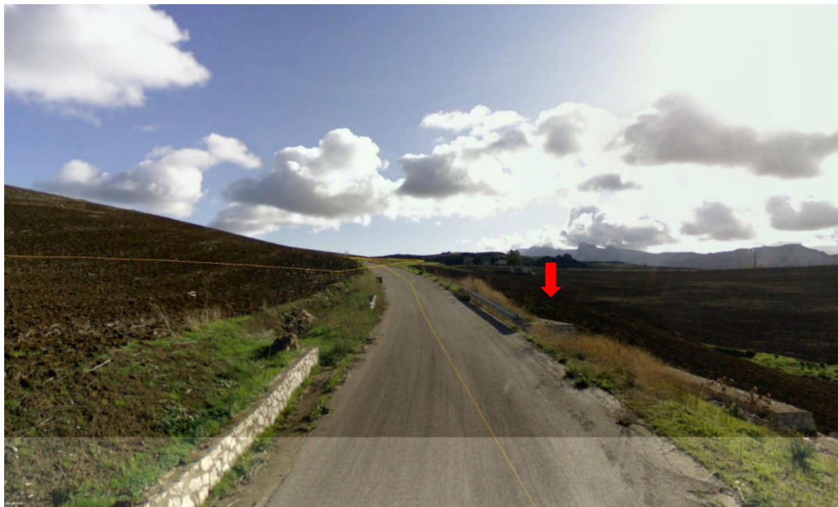
Figura 94. Vista attraversamento con scatolare
