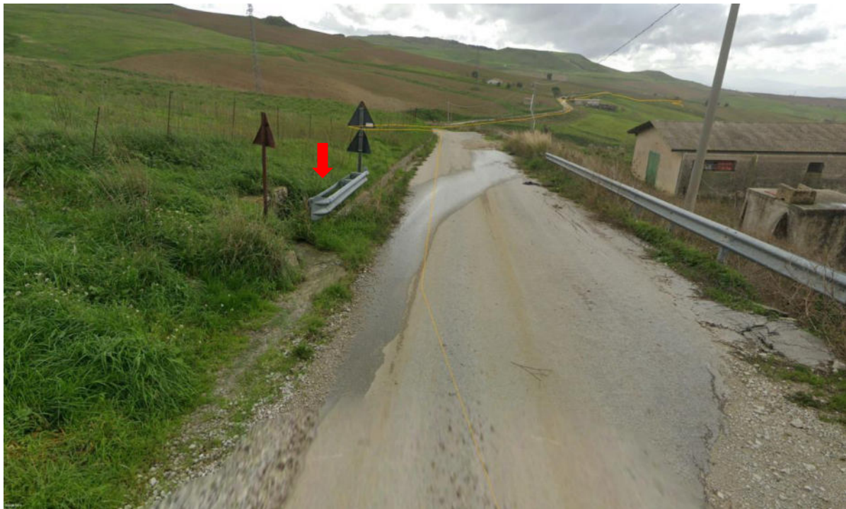
Figura 164. Vista attraversamento con scatolare in cls
