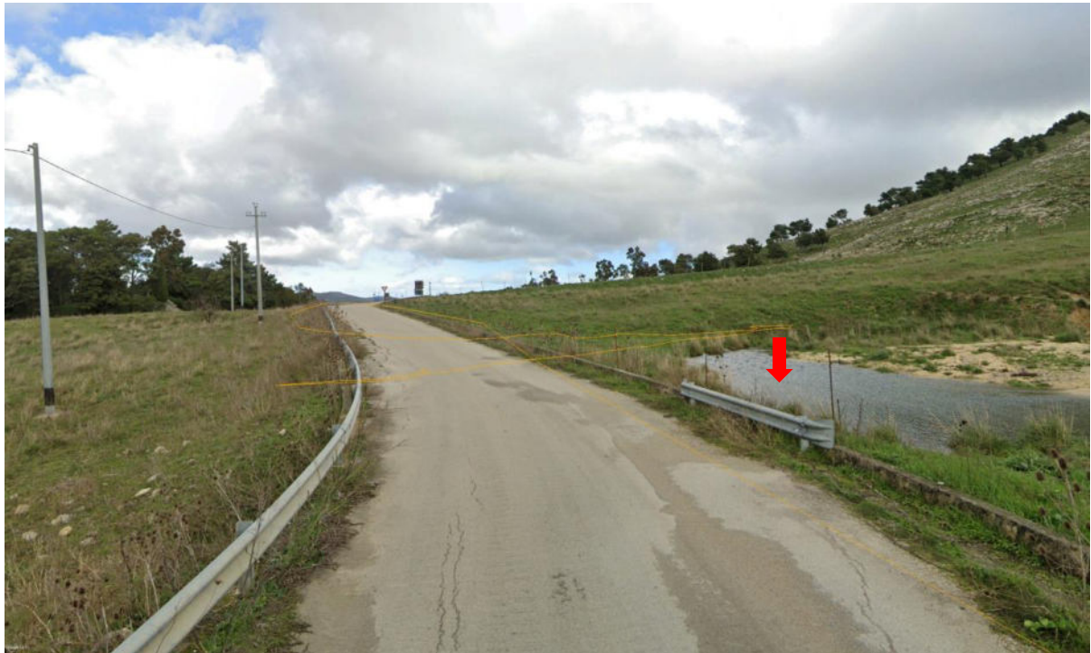
Figura 172. Vista attraversamento con scatolare in cls
