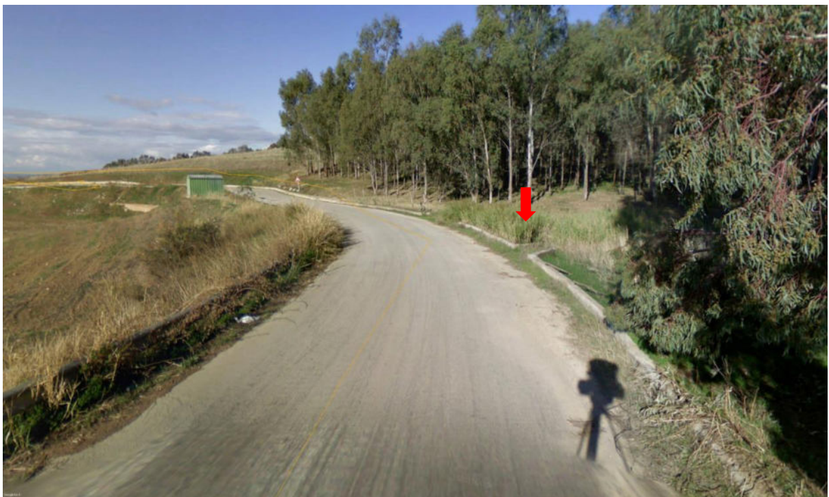
Figura 72. Vista attraversamento con scatolare in cls
