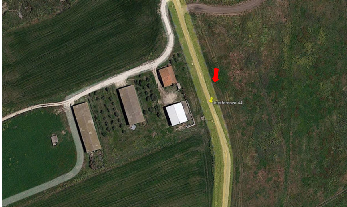
Figura 97. Ortofoto attraversamento con scatolare in cls
