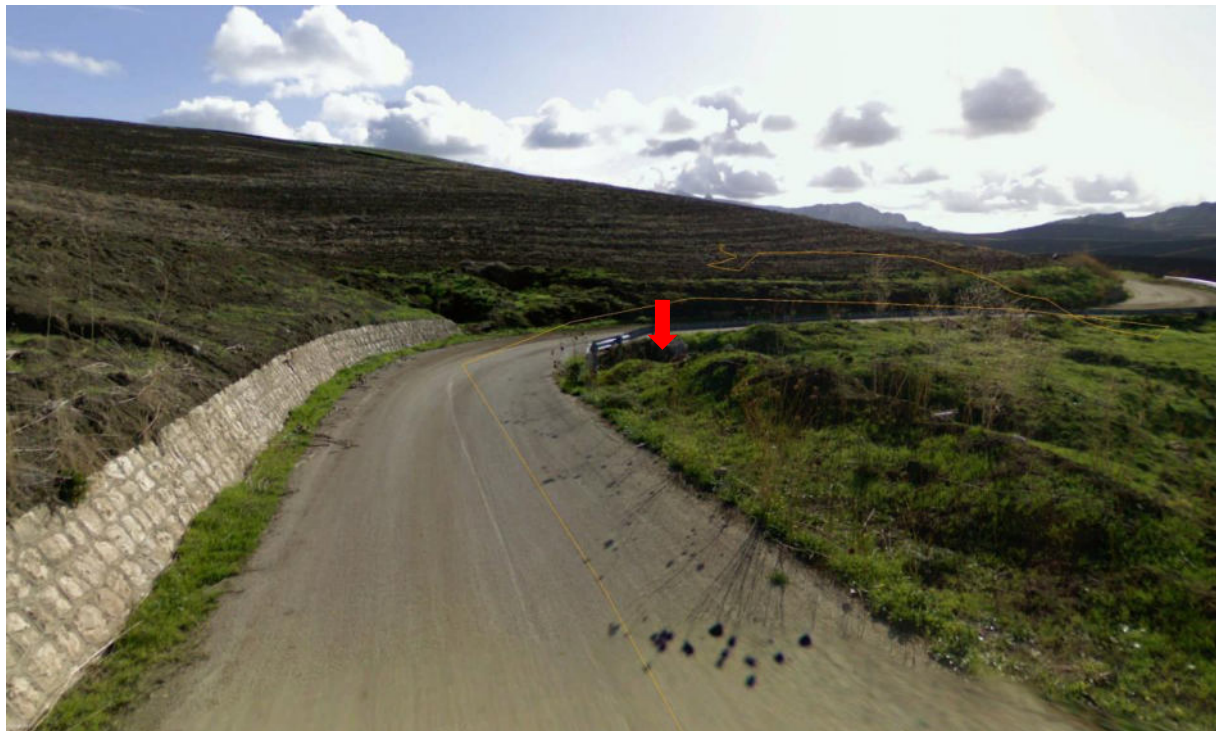
Figura 78. Vista attraversamento con scatolare in cls
