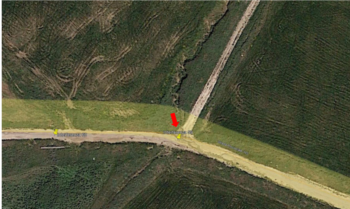
Figura 127. Ortofoto attraversamento con scatolare in cls
