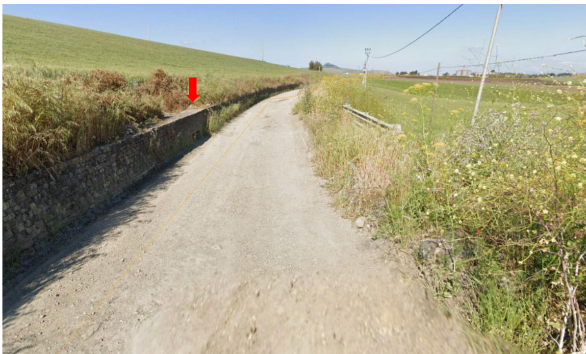
Figura 34. Vista attraversamento con scatolare in cls
