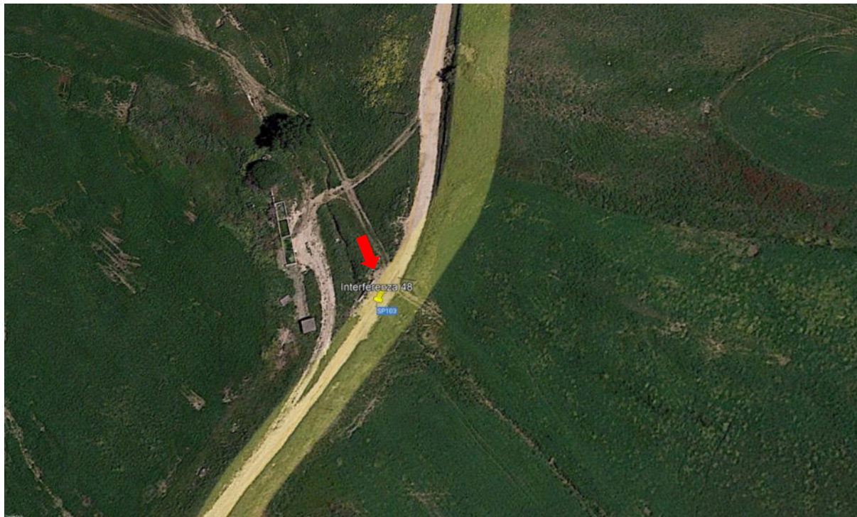
Figura 105. Ortofoto attraversamento con scatolare in cls
