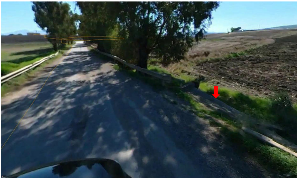
Figura 14. Vista attraversamento con scatolare in cls
