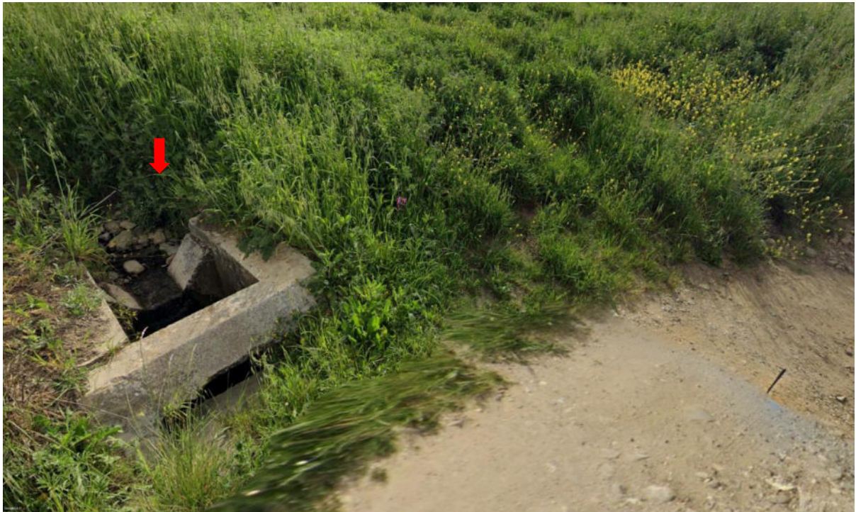
Figura 136. Vista attraversamento con scatolare in cls
