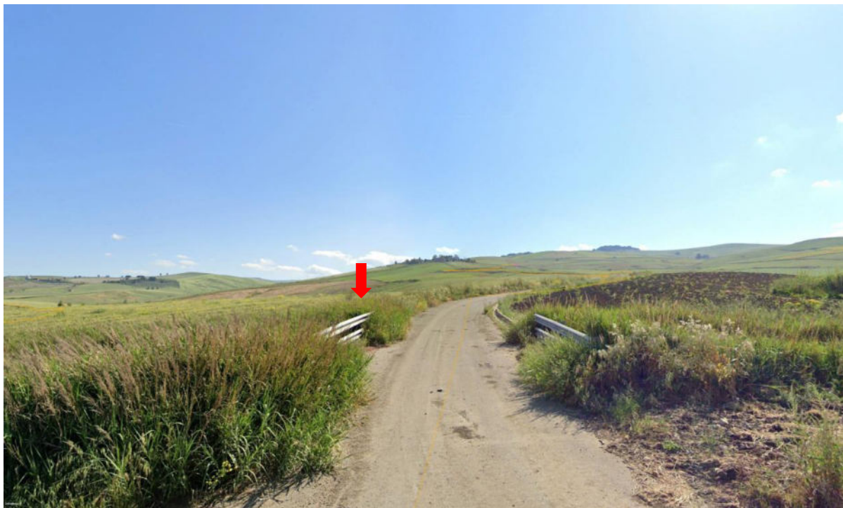
Figura 42. Vista attraversamento con scatolare in cls su reticolo idrografico
