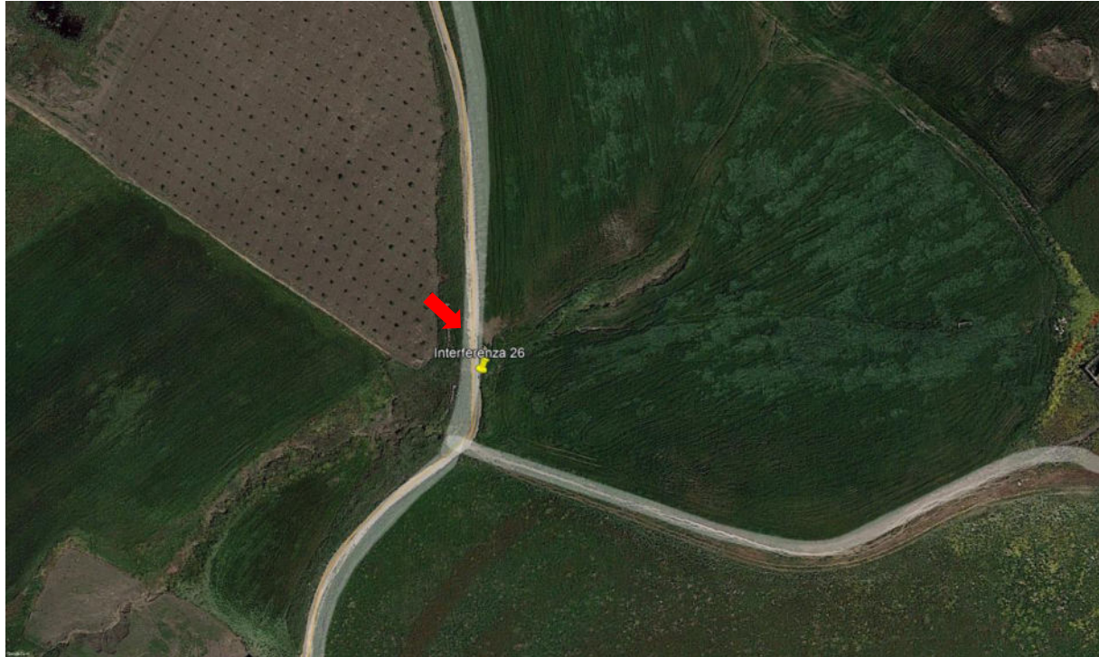
Figura 61. Ortofoto attraversamento con scatolare in cls
