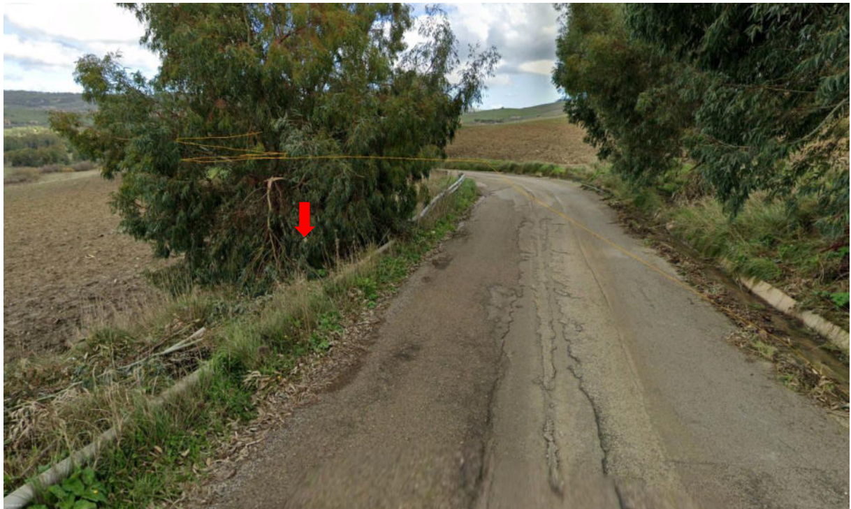
Figura 212. Vista attraversamento con scatolare in cls
