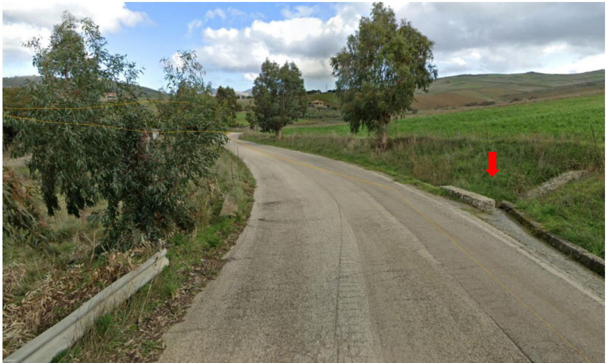
Figura 216. Vista attraversamento con scatolare in cls
