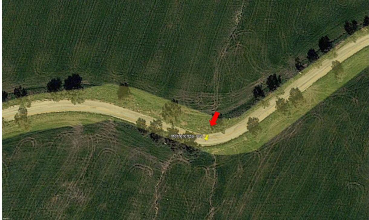
Figura 211. Ortofoto attraversamento con scatolare in cls
