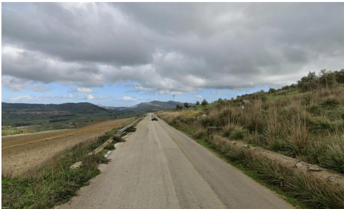
Figura 184. Vista attraversamento con scatolare in cls
