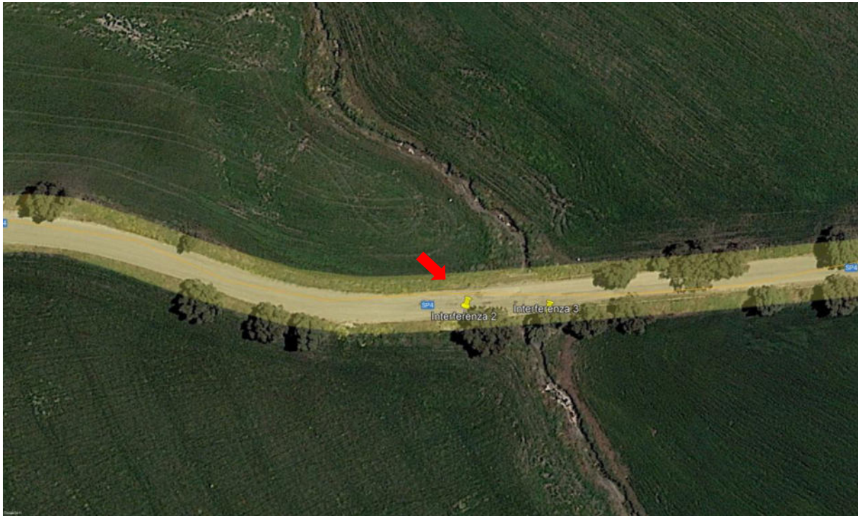
Figura 13. Ortofoto attraversamento con scatolare in cls
