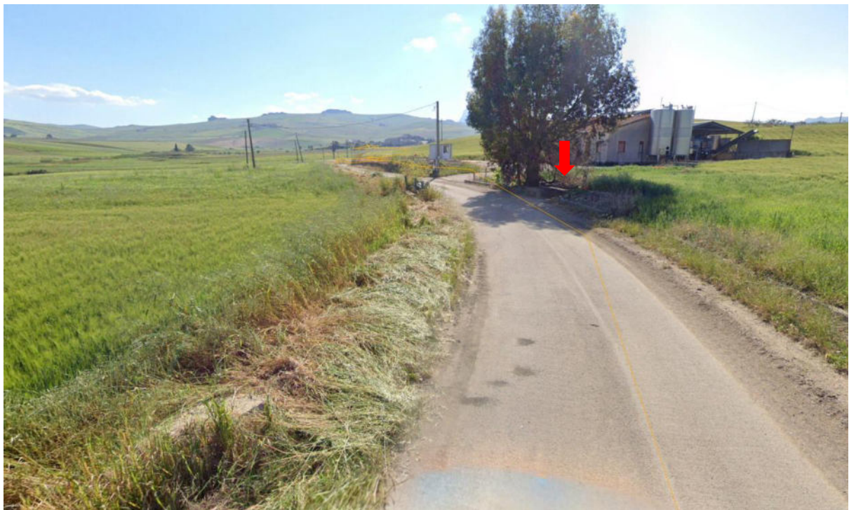
Figura 32. Vista attraversamento con scatolare in cls
