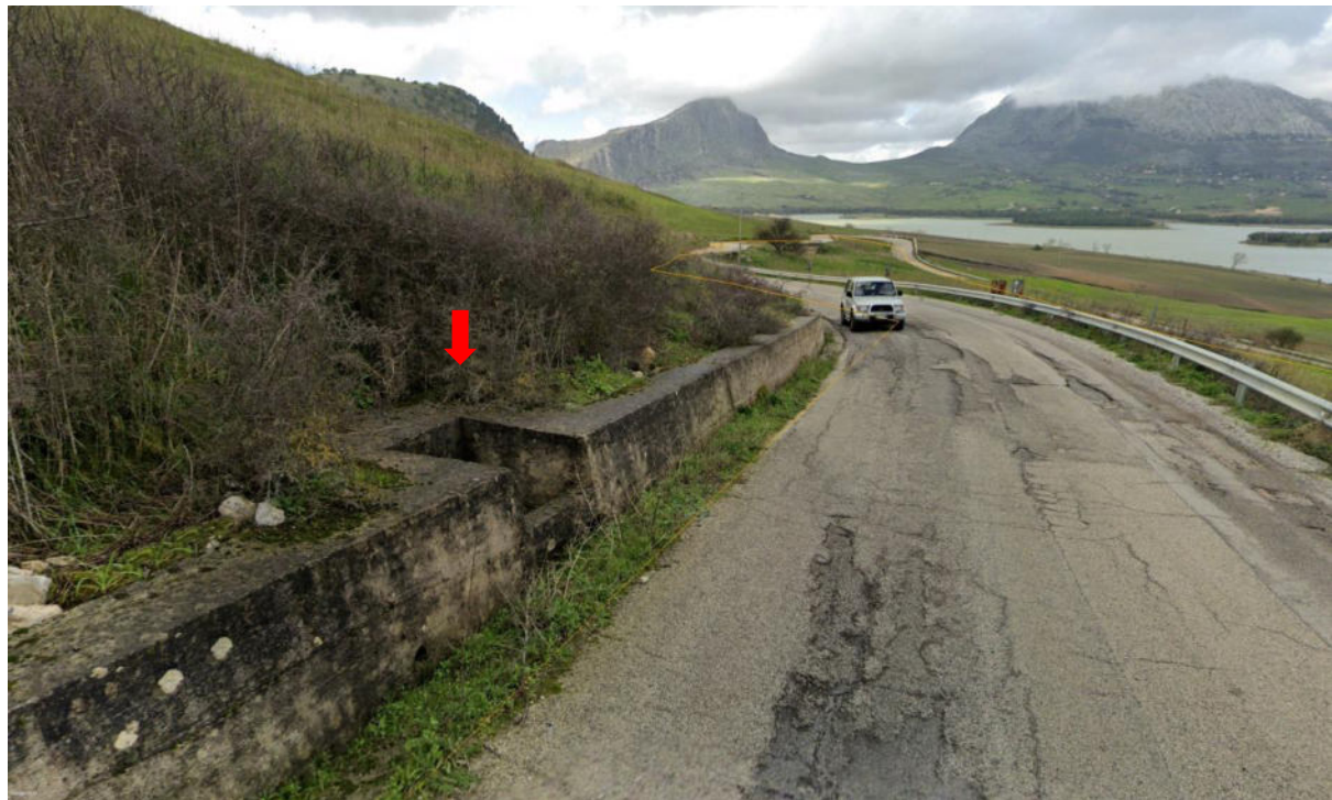
Figura 194. Vista attraversamento con scatolare in cls
