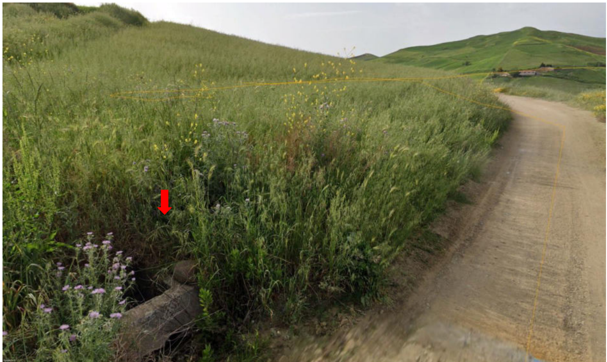
Figura 132. Vista attraversamento con scatolare in cls
