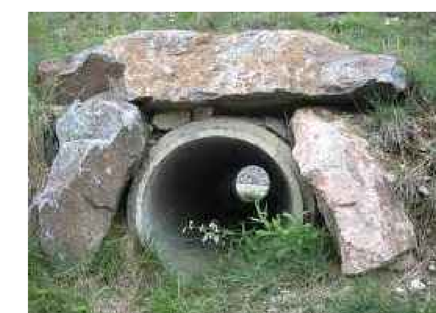
Particolare passaggio faunistico Scala 1:10
