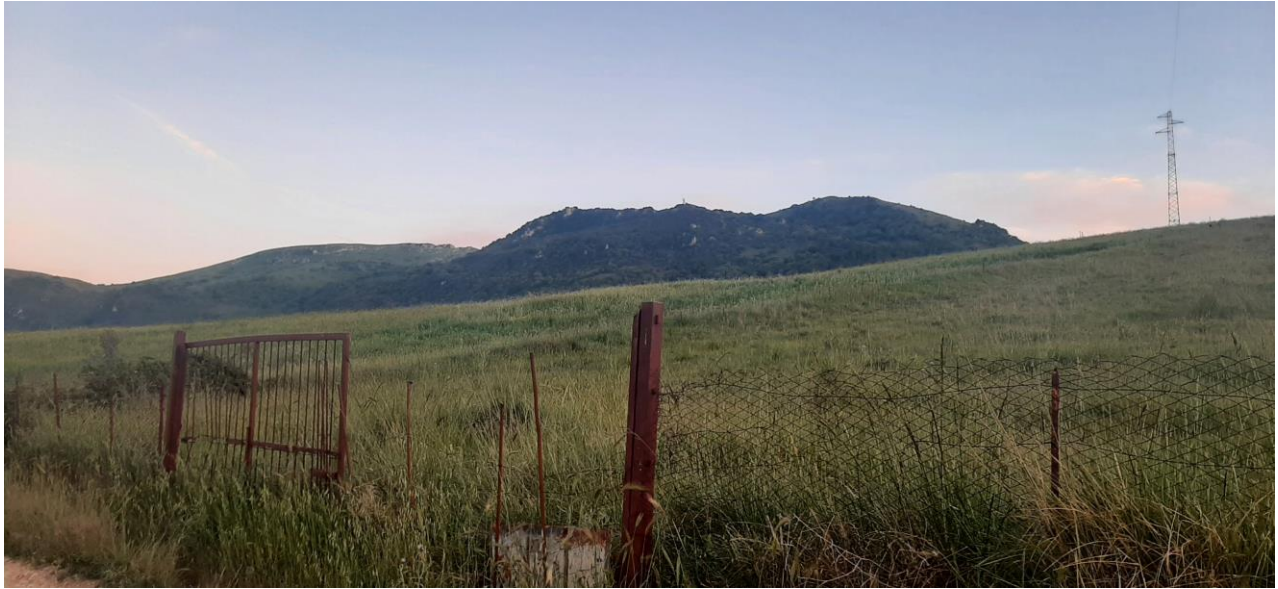
Figura 103. Stato dei luoghi ante operam della nuova Stazione Terna e Stazione Utente Palastanga.
