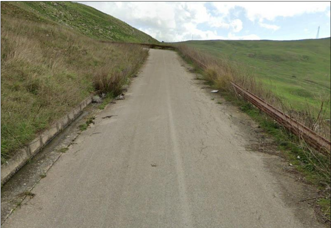
Figura 74. Tratto della SP 102 nel quale verrà interrato il cavidotto 36 kV, che attraversa l'habitat 6220*.
