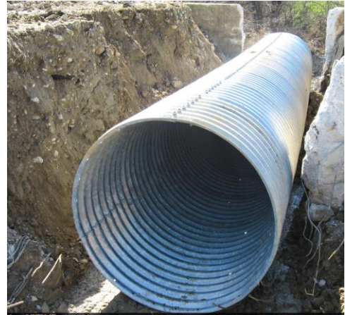
Figura 4. Esempio tubo Armco.
