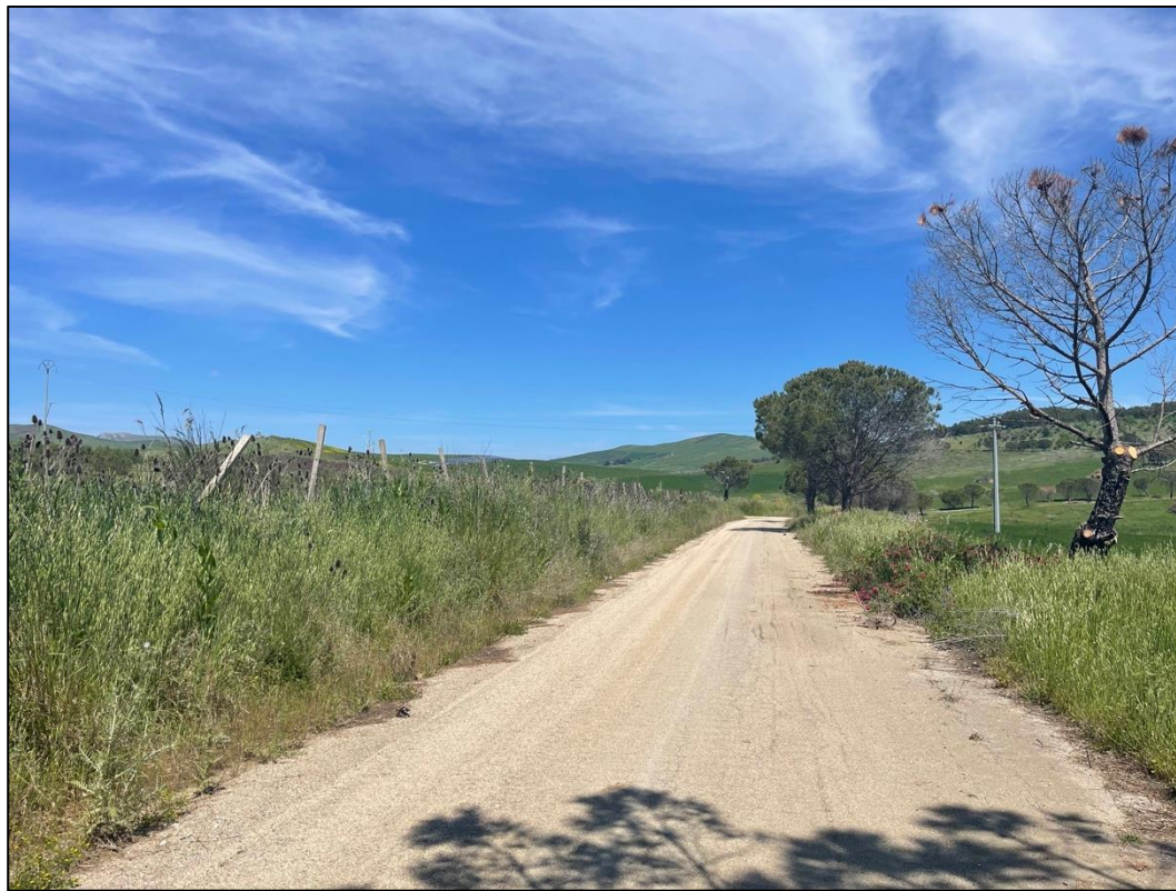
Foto 45 - Panoramica UR 19 (cavidotto interrato)
