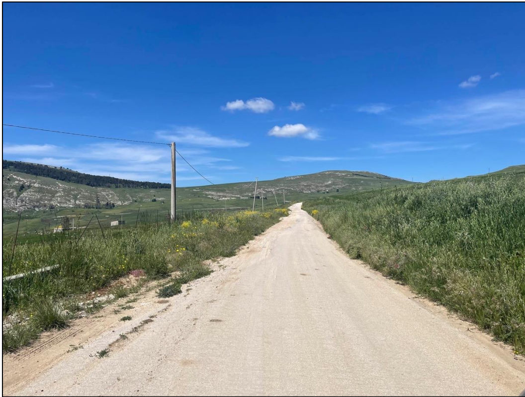
Foto 51 - Panoramica UR 21 (cavidotto interrato)
