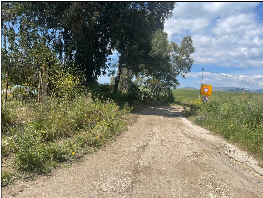
Foto 24 - Panoramica UR 12 (cavidotto interrato)
