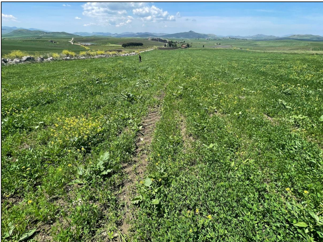
Foto 20 - Panoramica UR 09 (impianto fotovoltaico area Celso)
