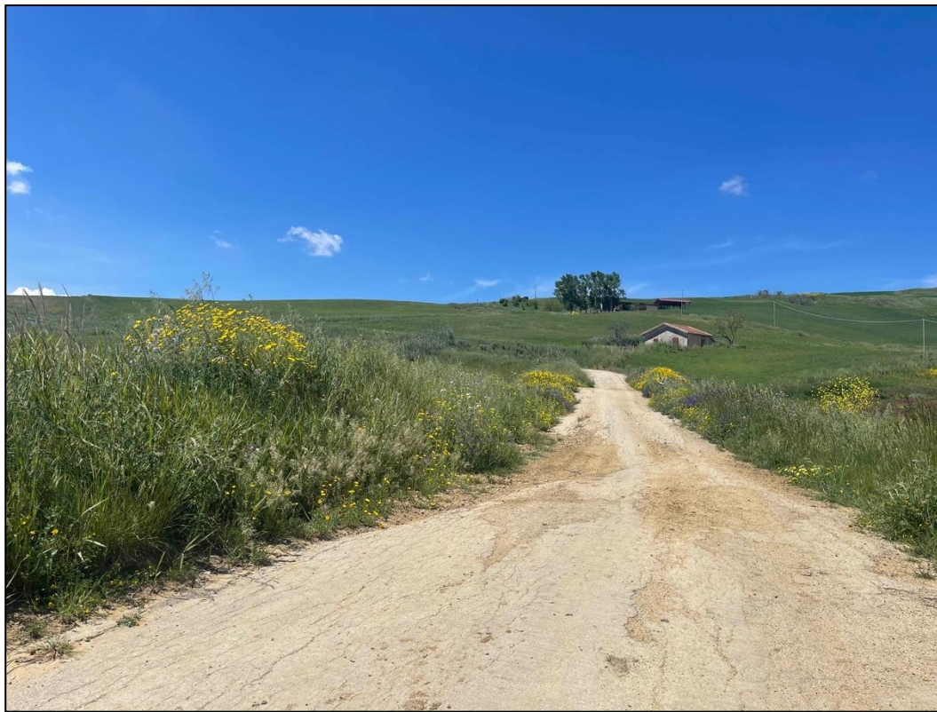
Foto 49 - Panoramica UR 20 (cavidotto interrato)
