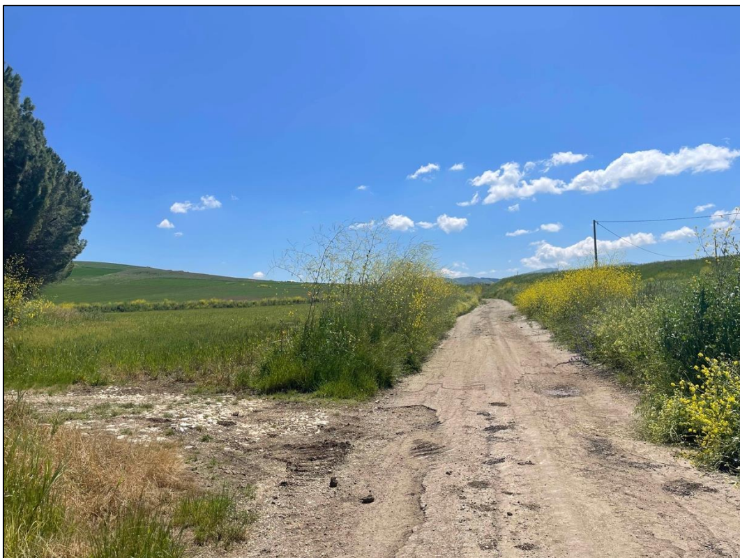
Foto 16 - Panoramica UR 07 (cavidotto interrato)
