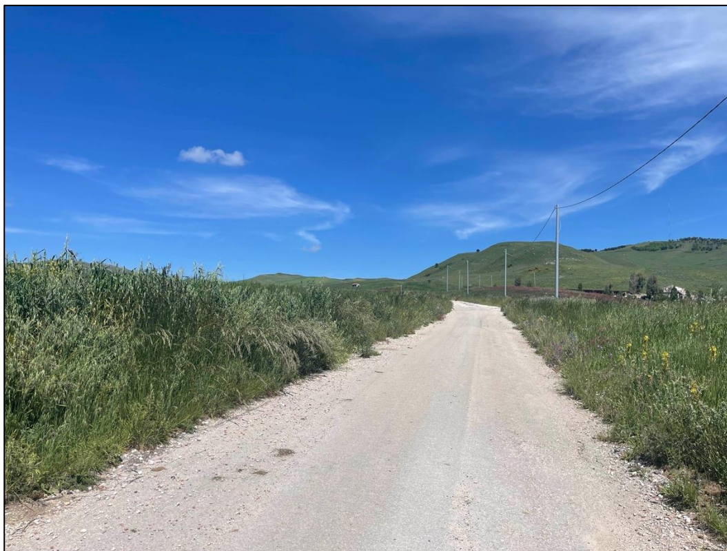
Foto 50 - Panoramica UR 20 (cavidotto interrato)
