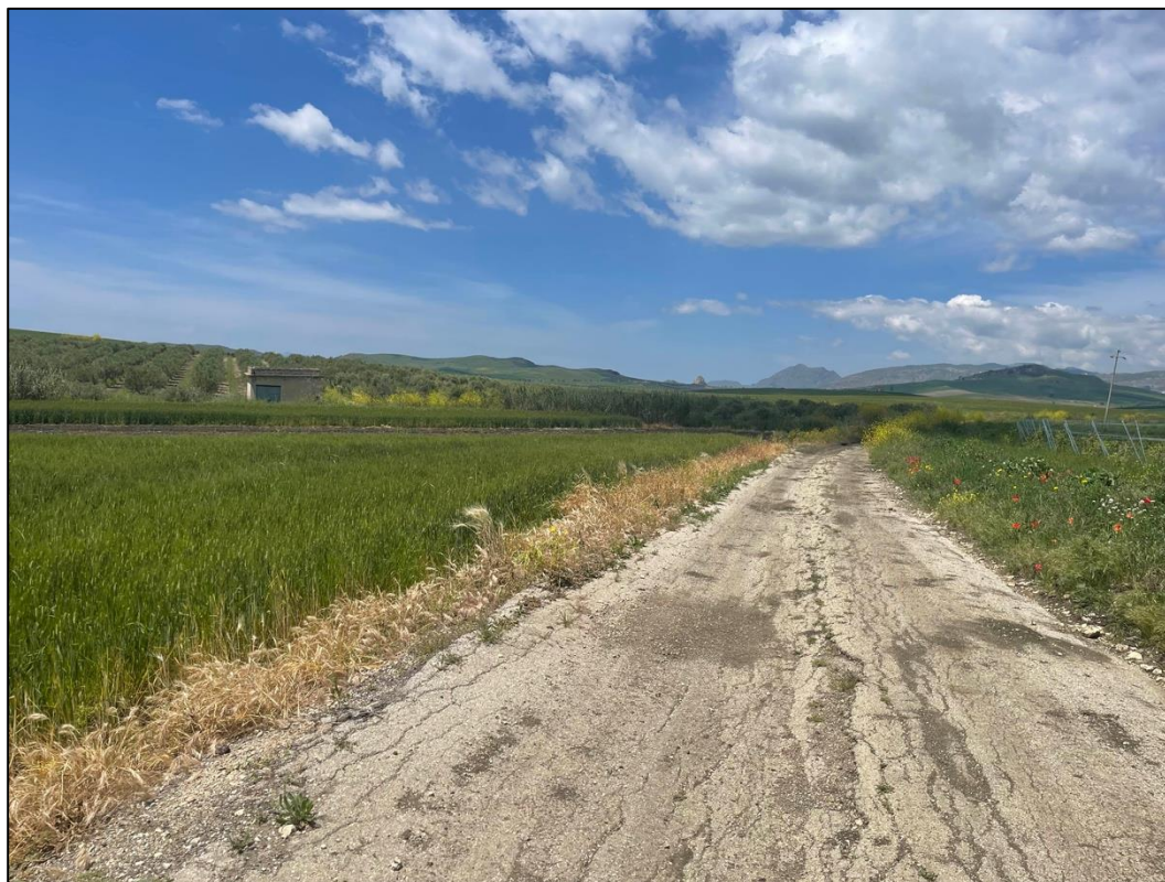
Foto 26 - Panoramica UR 12 (cavidotto interrato)
