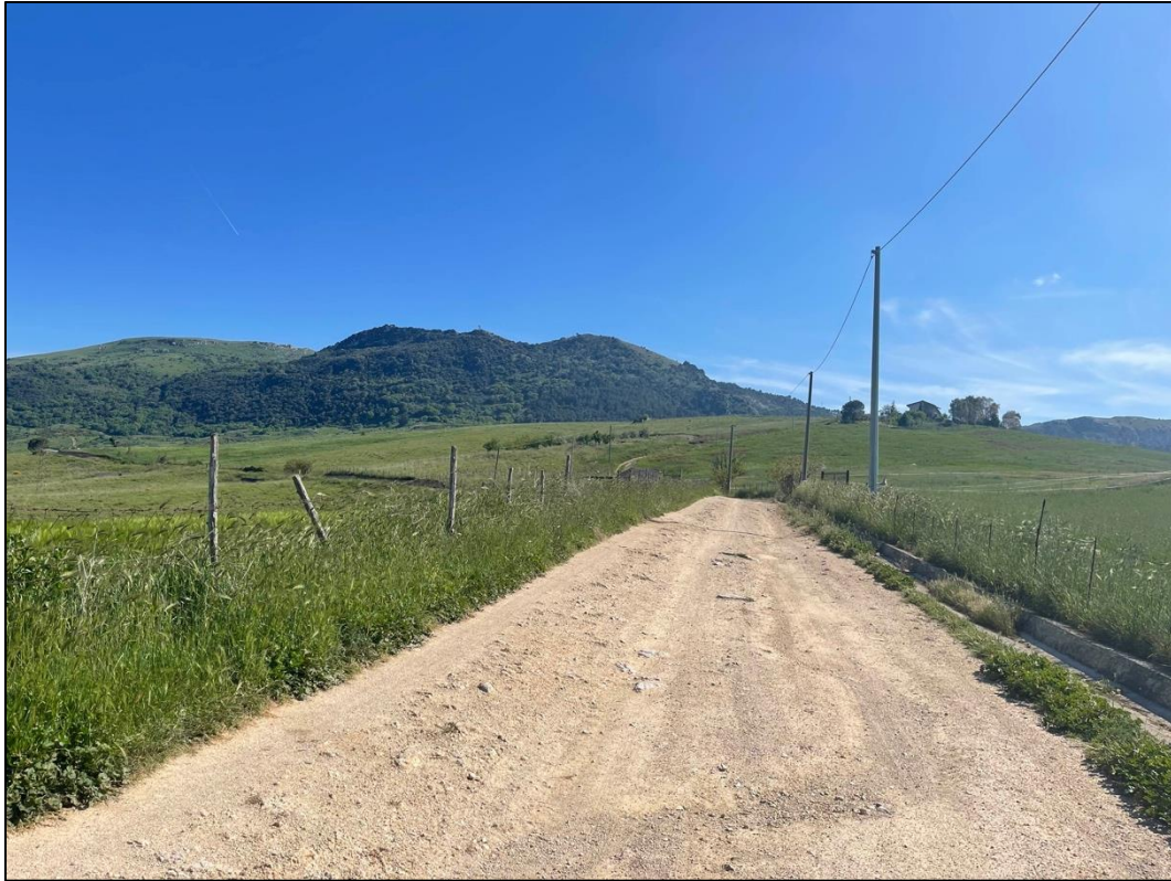
Foto 59 - Panoramica UR 23 (cavidotto interrato)
