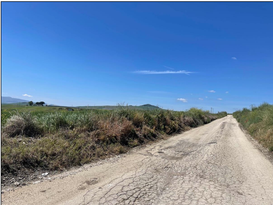
Foto 4 - Panoramica UR 02 (cavidotto interrato)
