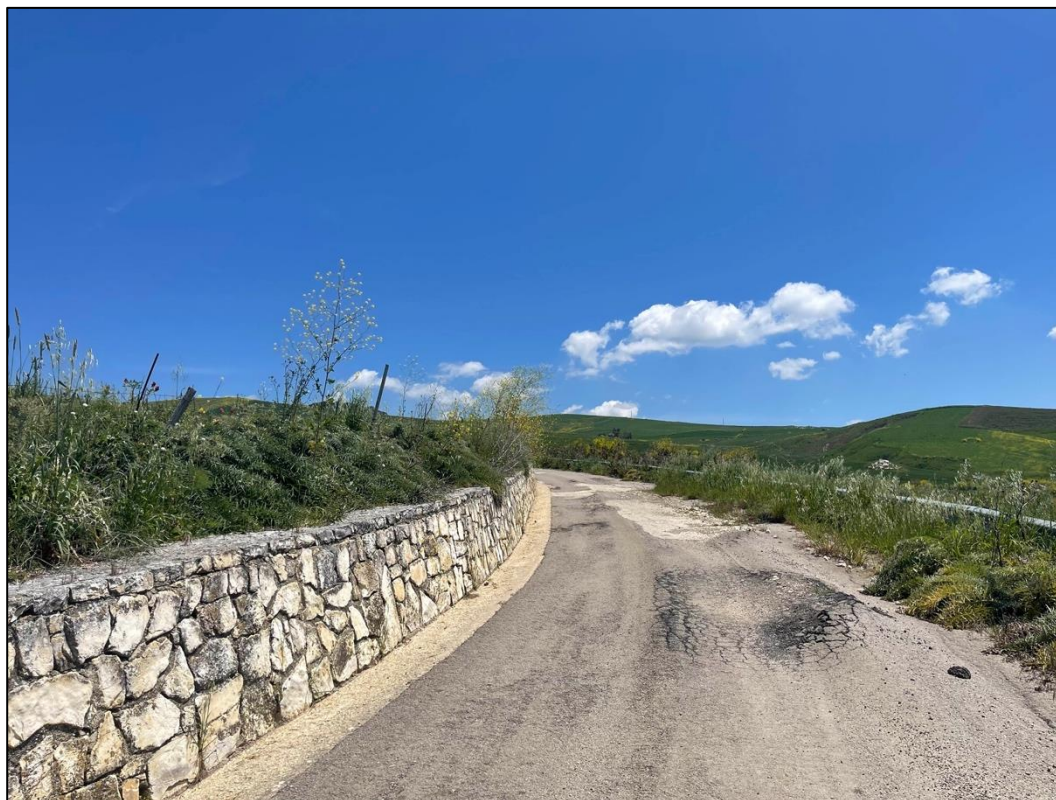
Foto 10 - Panoramica UR 04 (cavidotto interrato)
