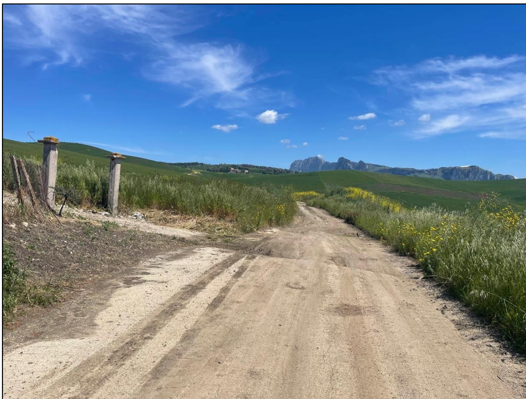
Foto 44 - Panoramica UR 19 (cavidotto interrato)
