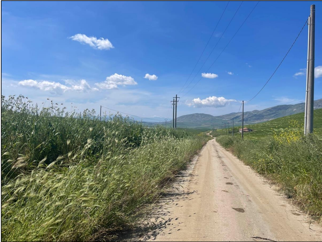
Foto 47 - Panoramica UR 20 (cavidotto interrato)
