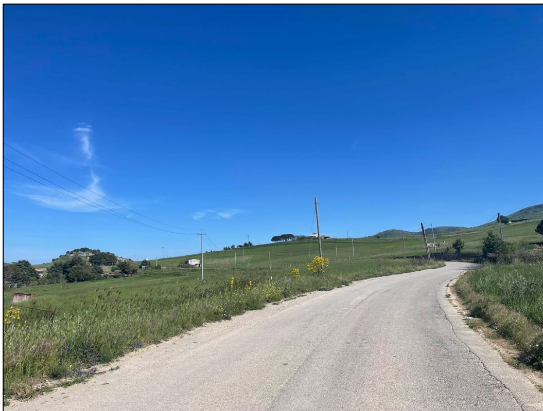
Foto 58 - Panoramica UR 23 (cavidotto interrato)
