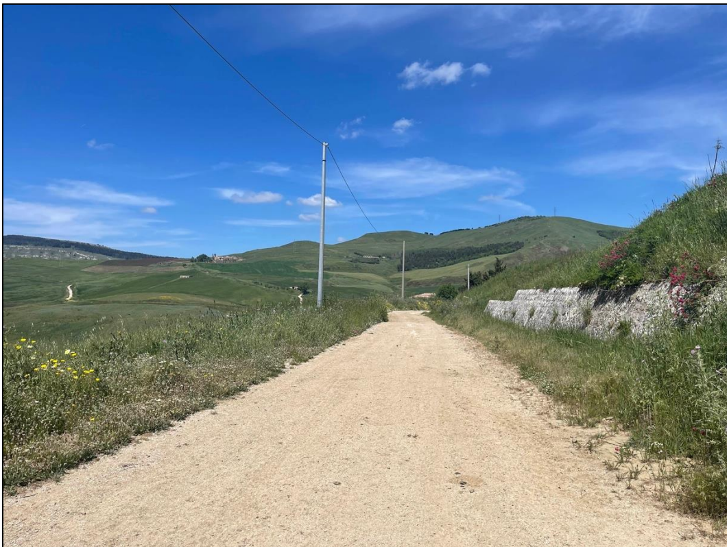
Foto 48 - Panoramica UR 20 (cavidotto interrato)
