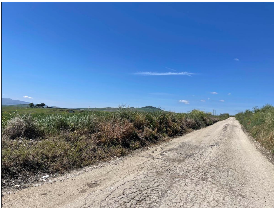
Foto 8 - Panoramica UR 04 (cavidotto interrato)
