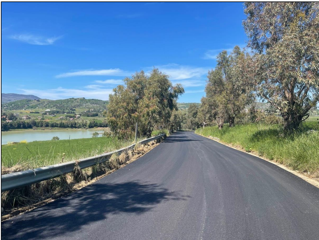
Foto 56 - Panoramica UR 22 (cavidotto interrato)
