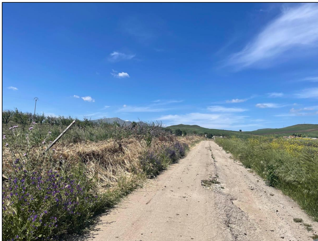
Foto 46 - Panoramica UR 20 (cavidotto interrato)
