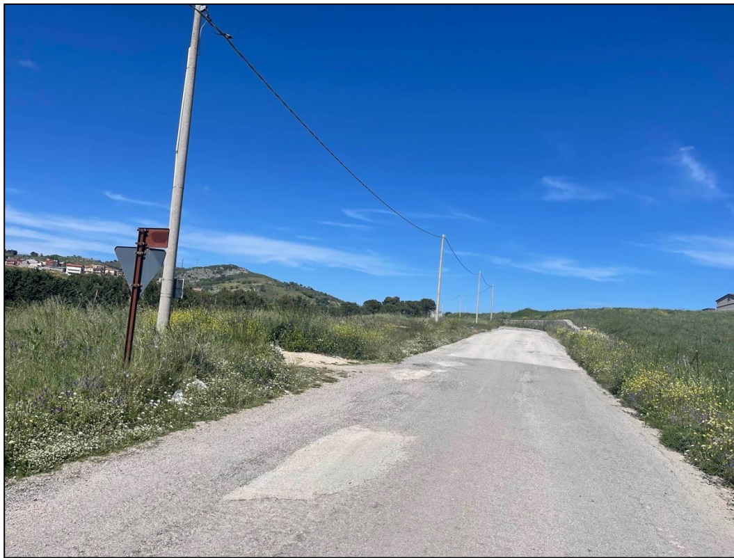
Foto 57- Panoramica UR 23 (cavidotto interrato)
