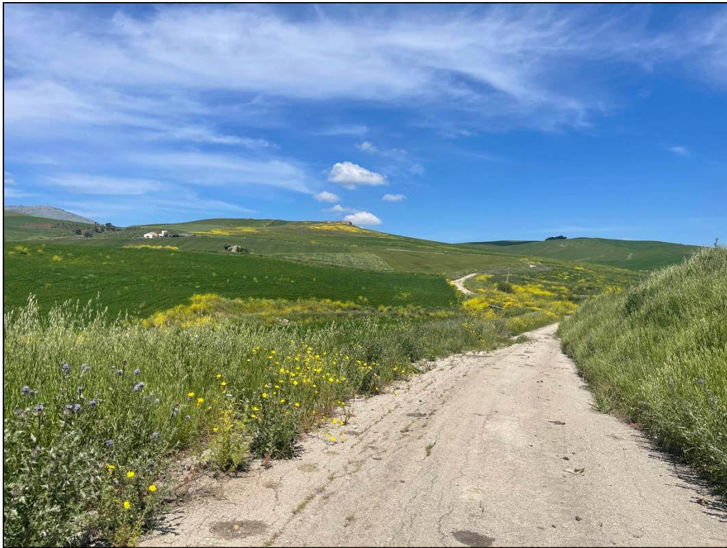
Foto 27 - Panoramica UR 12 (cavidotto interrato)
