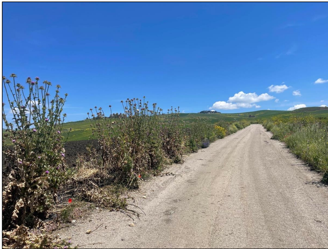
Foto 9 - Panoramica UR 04 (cavidotto interrato)
