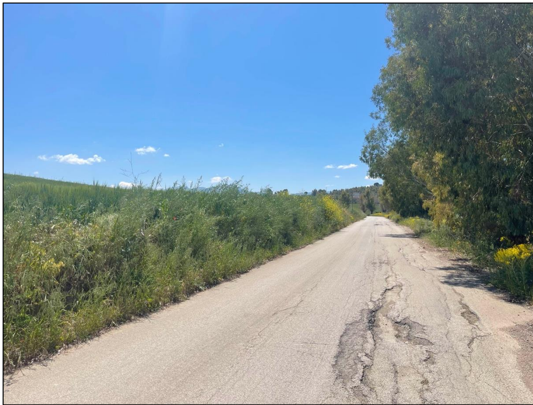
Foto 5 - Panoramica UR 03 (cavidotto interrato)
