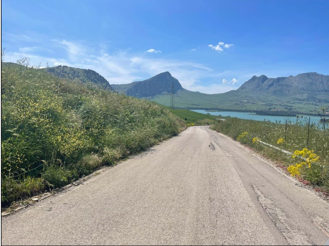
Foto 55 - Panoramica UR 22 (cavidotto interrato)
