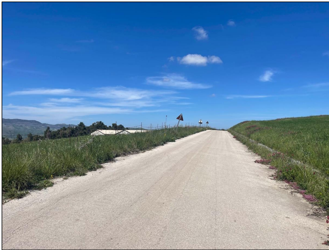
Foto 53 - Panoramica UR 21 (cavidotto interrato)
