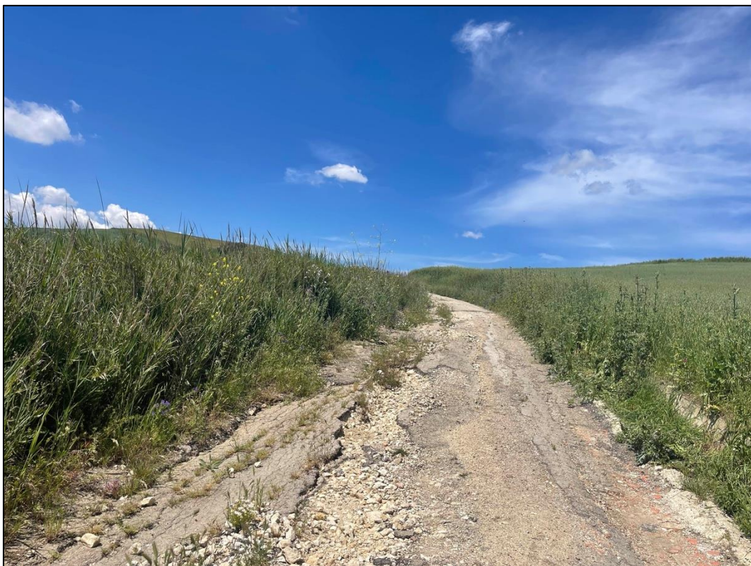
Foto 28 - Panoramica UR 12 (cavidotto interrato)
