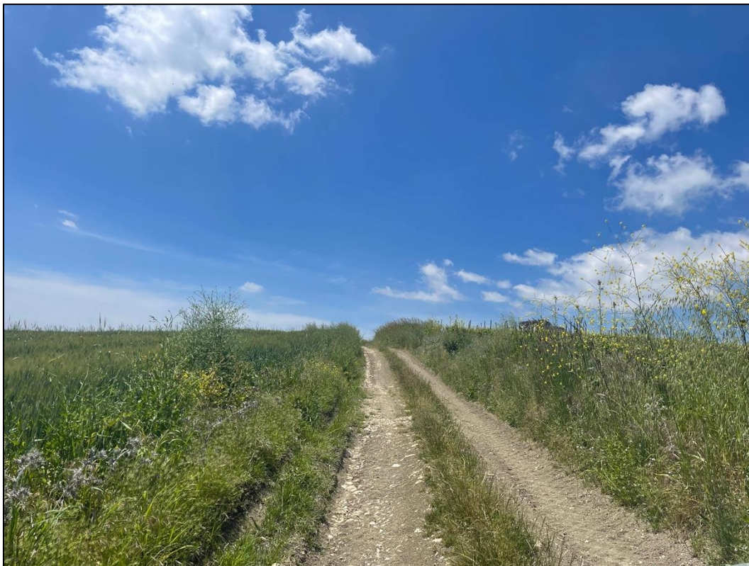
Foto 32 - Panoramica UR 15 (cavidotto interrato e viabilità per area Torre dei Fiori)
