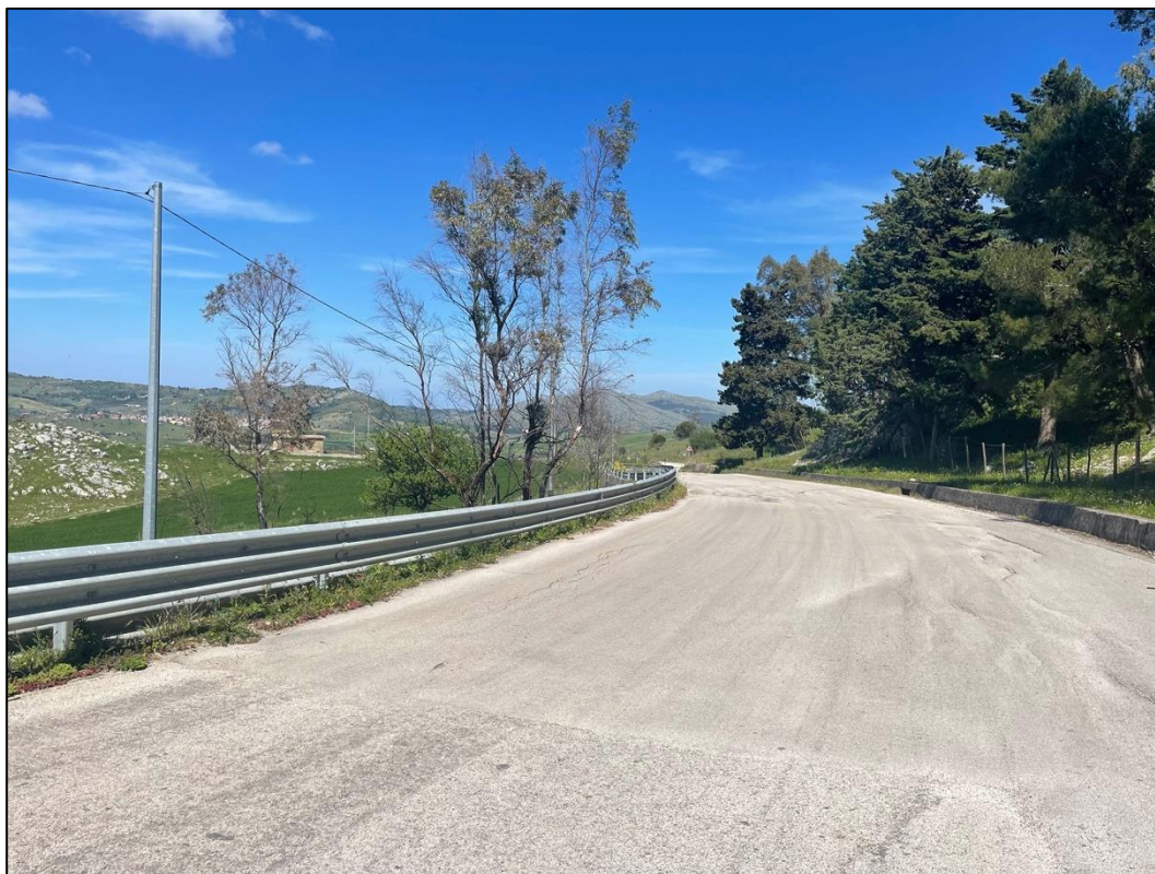
Foto 54 - Panoramica UR 22 (cavidotto interrato)
