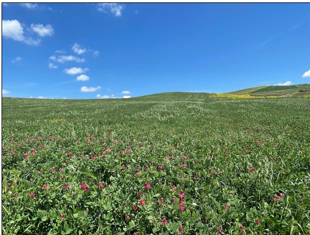
Foto 22 - Panoramica UR 11 (impianto fotovoltaico area Tagliavia)
