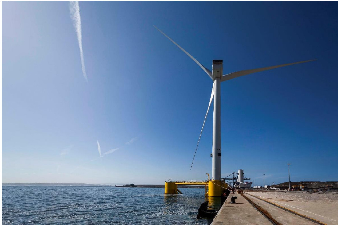
Figura 6-4 - Fasi di assemblaggio della piattaforma galleggiante (Fonte Windfloat Atlantic Project)
