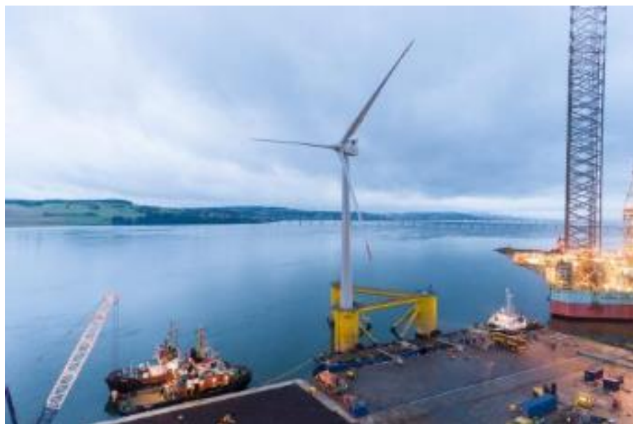
Figura 6-2 - Assemblaggio piattaforma galleggiante (Fonte kinkardine -Cobra)
