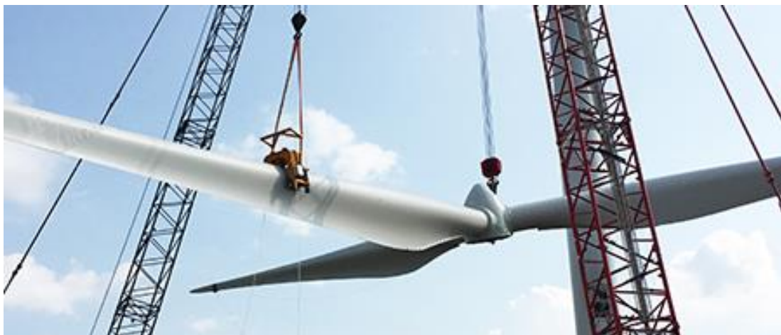
Figura 6-5 - Sollevamento del rotore (Fonte: Elronic Wind solution)
