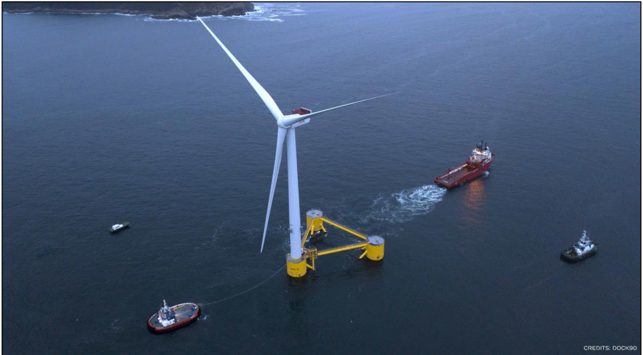
Figura 2.27 – Esempio dell'operazione di rimorchio (Fonte Windfloat Atlantic Project)
