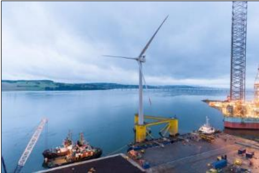
Figura 2.23 – Assemblaggio piattaforma galleggiante (Fonte kinkardine -Cobra)
