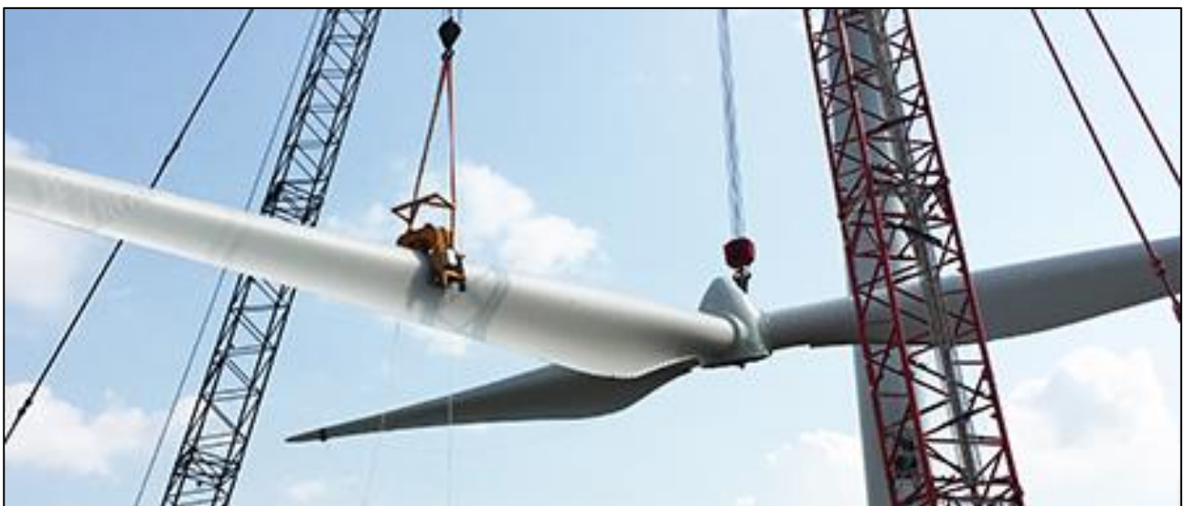
Figura 2.26 – Sollevamento del rotore (Fonte: Elronic Wind solution)
