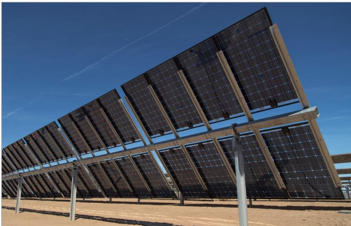
Figura III.3- Esempio struttura + modulo FV bifacciale
