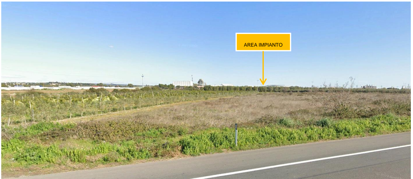
Figura 14-3: Vista dal Punto A lungo la SS7 verso l'area di impianto
