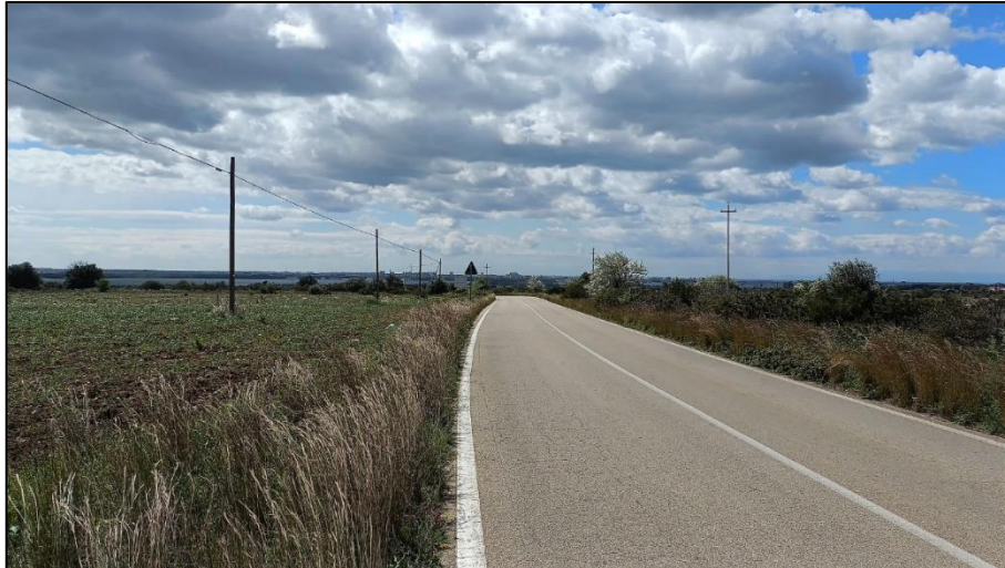
Foto 2.1.1.A – Strada asfaltata SP77 relativa all’intersezione del Cavidotto MT con la ZSC/ZPS IT9130002 “Masseria Torre Bianca” (posizione P8, Allegato)
