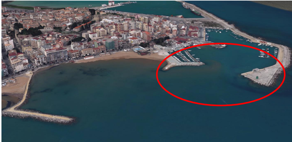
Figura 7.1 - Localizzazione area di intervento (cerchiata in rosso)
