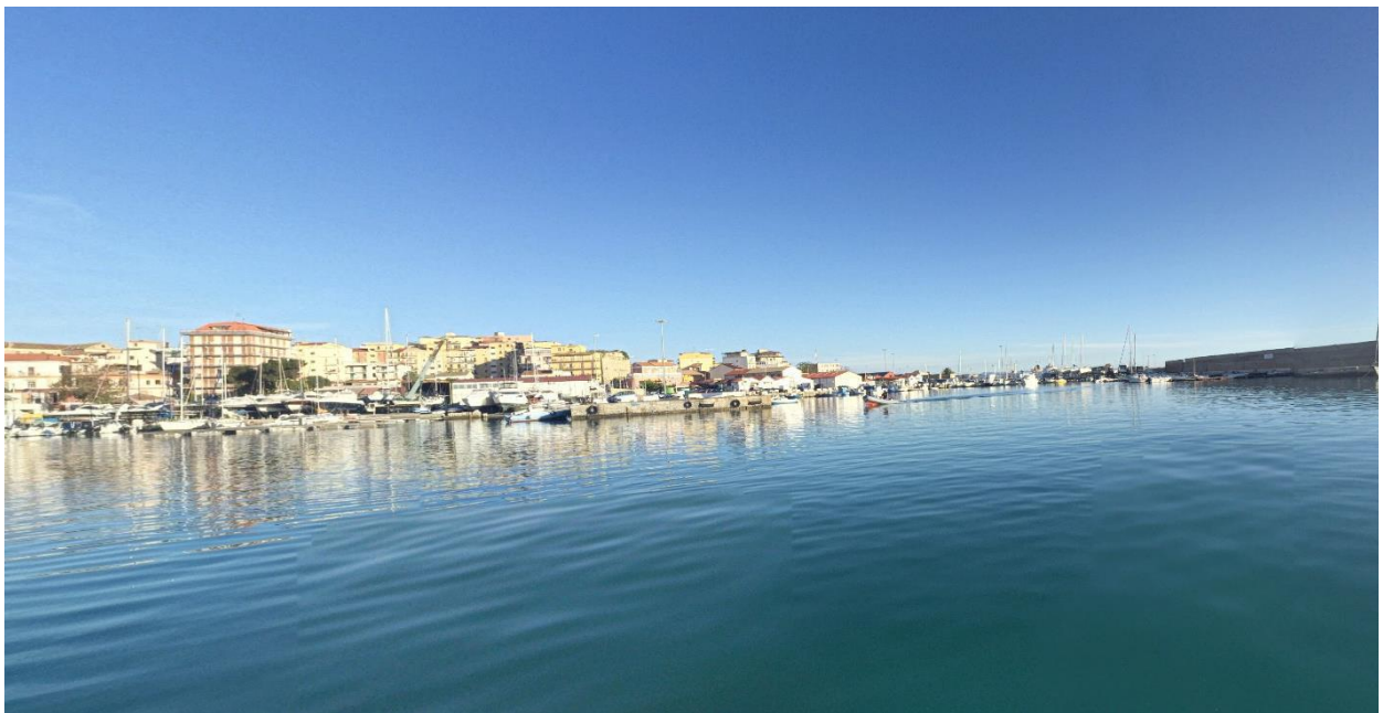
Figura 3.5: Foto bacino porto vecchio dal molo sopraflutto 1
