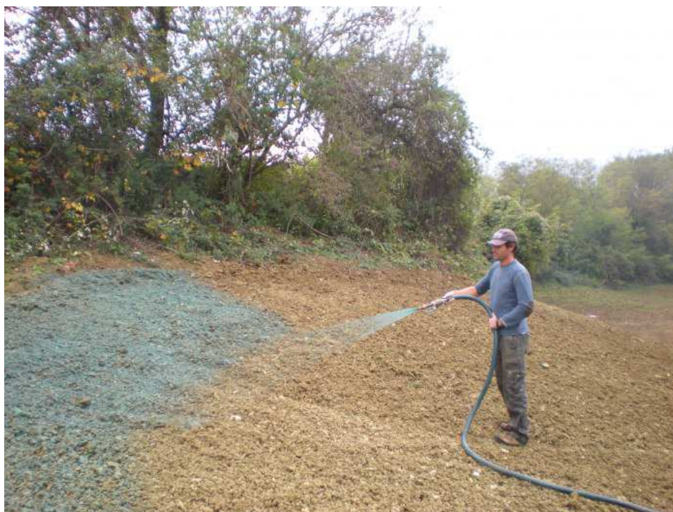
Fig. Esempio di inerbimento tramite idrosemina.
